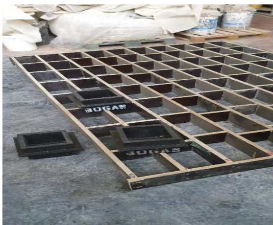
Figura 11 - Moldes para betão
