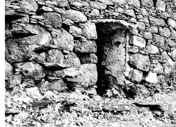
Mina de água, muro e escadas, Ribeira João Gomes
