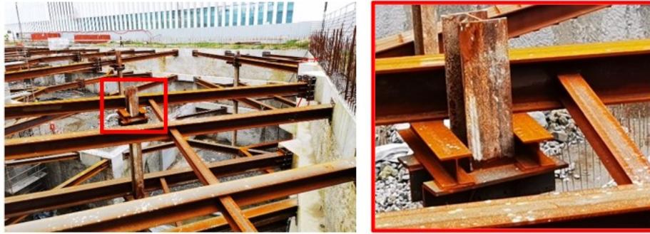
Figura 4.30 – Pormenorização das ligações entre perfis da solução de canto
