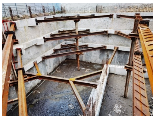
Figura 3.2 – Enquadramento visual da estrutura de suporte a sul do lote
