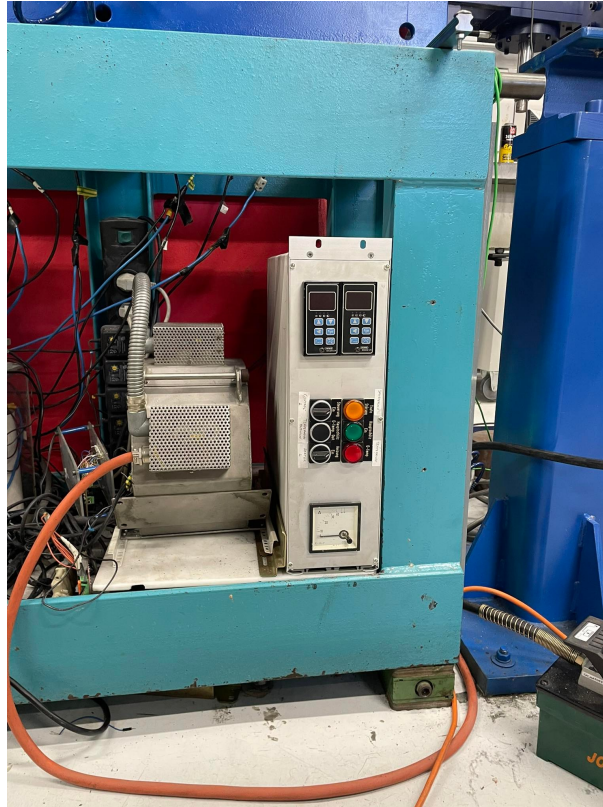
Figura 3.9: Forno elétrico e respetivo controlador
