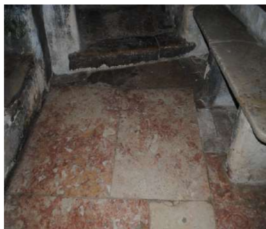
Figura 2.16 Pavimento da Cozinha em lajedo.
