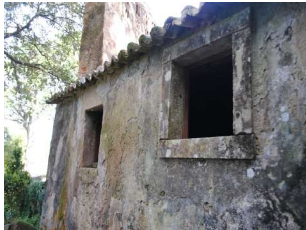
Figura 2.13 Parede exterior da Cozinha.
