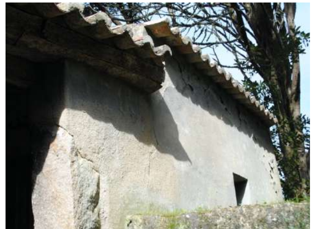
Figura 2.8 Pormenor da parede exterior da Capela da Paixão.
