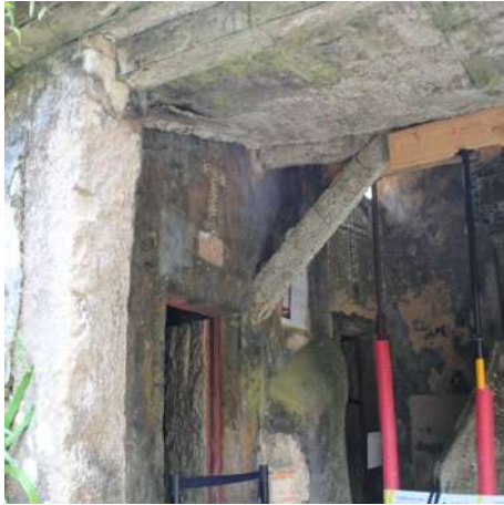
Figura 2.9 Pormenor de cortiça na viga e na porta de entrada para a Igreja.
