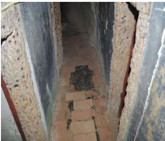
Figura 2.17 Corredor de acesso às celas.
