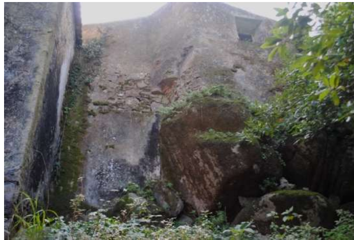
Figura 2.6 Pormenor do afloramento da rocha granítica.
