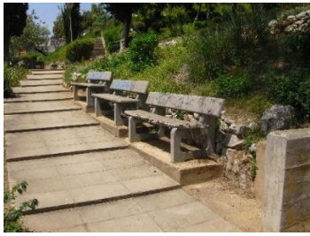
Figura 72: Mobiliário urbano antes da requalificação (Fonte: CMS)
