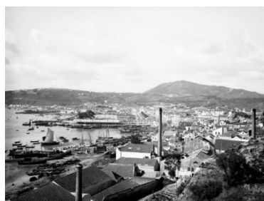
Figura 53: Vista sobre a cidade antes das obras do porto, a partir do jardim. As chaminés antigas das fábricas, hoje em dia só resta a chaminé do centro da imagem (Fonte: CMS)
