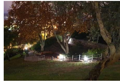
Figura 74: Sistema de iluminação (Fonte: CMS)
