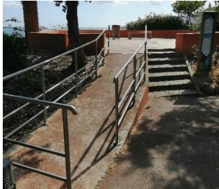
Figura 66: Rampa de acesso ao miradouro
