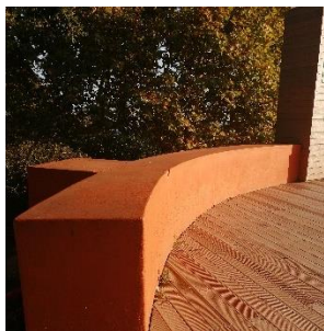
Figura 81: Muro que delimita o miradouro
