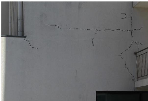
*Figura 2.5 - Anomalia A-C2 - fissuração orientada.*
