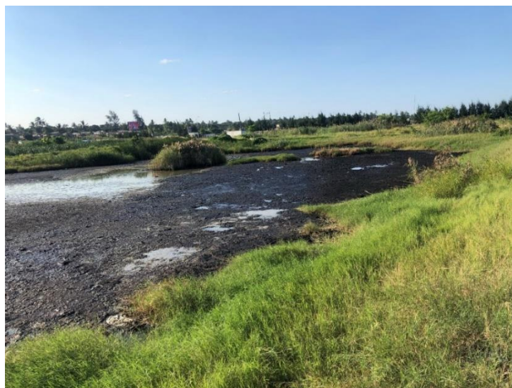
Figura 3.12 - Fotografia da lagoa anaeróbia da ETAR de Maputo
