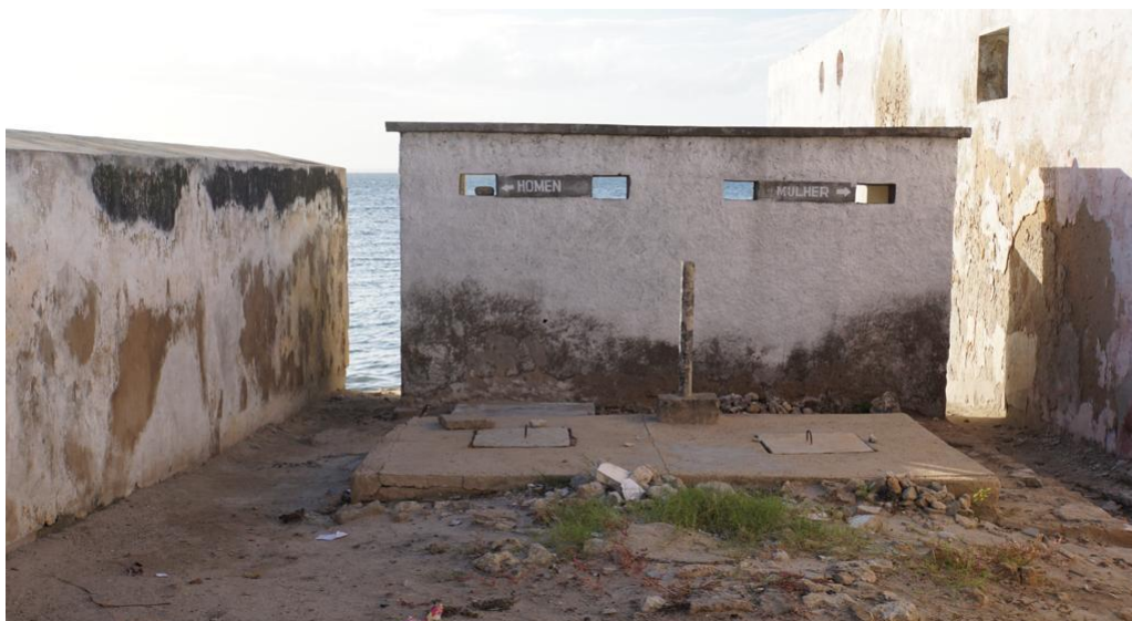
Figura 3.18 - Instalação partilhada junto ao mar na Ilha de Moçambique
