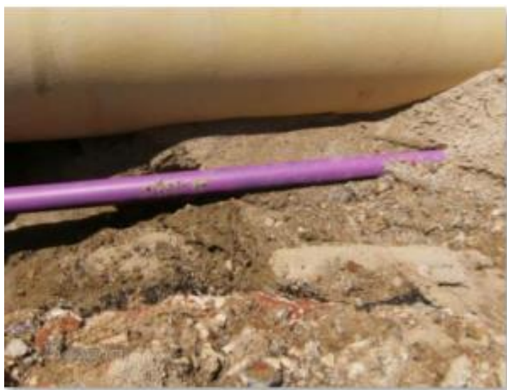
Figura 3.8 - Exemplo de identificação das tubagens de ART (Fonte: Urbanas, n.d.).
