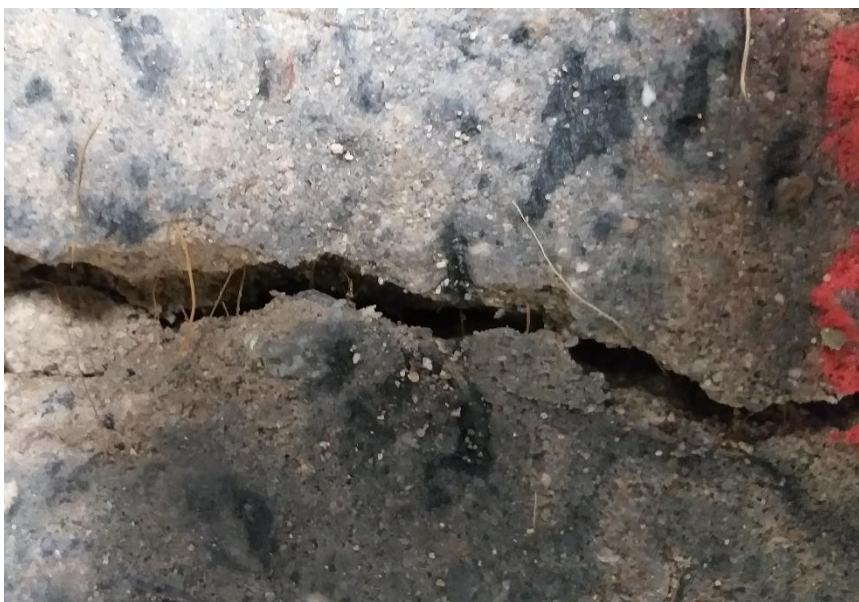
Figura 3.16 - Pormenor da fibra de coco a suportar a integridade estrutural da mistura de RCD com 3% de cimento com fibra de coco
