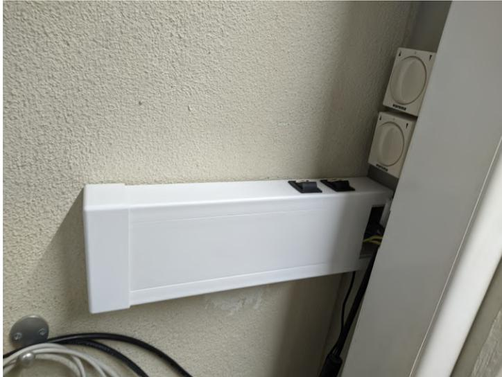
Figura 2.9: Controlador e interruptores dos estores
