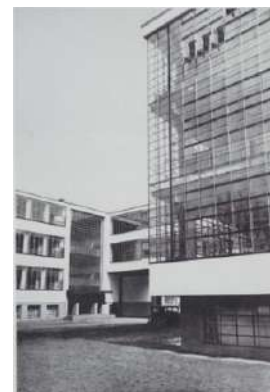
1 Walter Gropius, Edifício da escola Bauhaus (1925-1926), Dessau.
