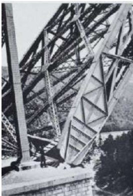
3 Eiffel, Gustav, Garabit Viaduct, detalhe de um pilar.
