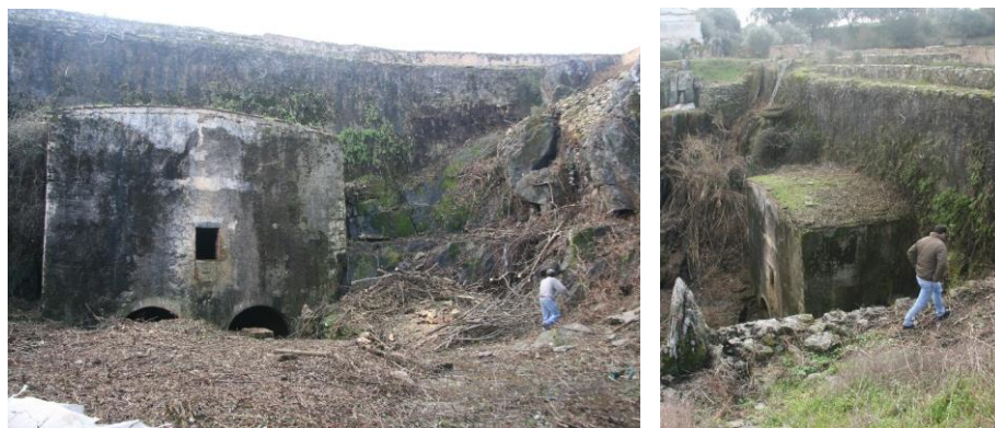
Figura 3.4 – Construção de alvenaria imediatamente a jusante da barragem do Monte Branco.
