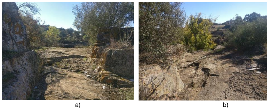
Figura 3.2 – Descarregadores de cheia da barragem do Monte Branco (vista de montante para jusante): a) esquerdo e b) direito.
