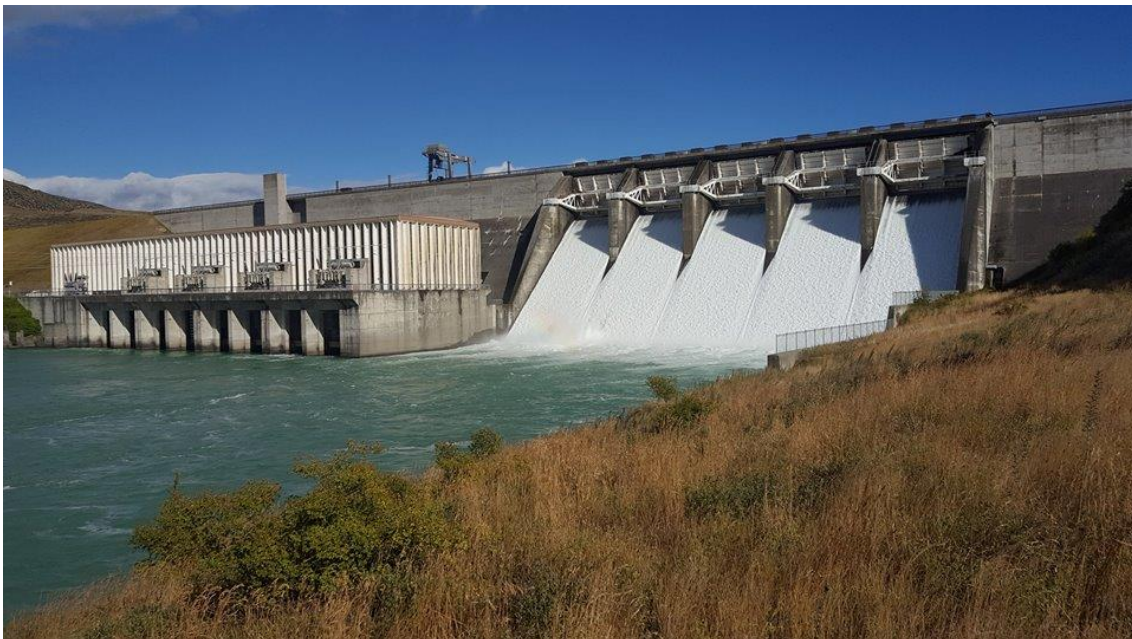
Figura 2.1- Descarregador de cheias da barragem de Aviemore, Nova Zelândia (in https://www.facebook.com/kevin.bird.336 acedido em 02/05/2018).
