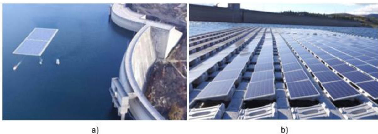
Figura 7 – Central solar fotovoltaica flutuante na albufeira do Alto do Rabagão – a) Enquadramento com a barragem; b) Distribuição dos painéis pela plataforma flutuante (C. M. Montalegre 2017)
