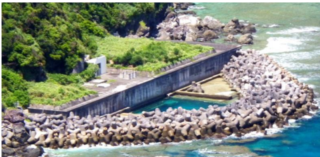
Figura 60 – Proteção marítima do projeto de Okinawa Yanbaru
