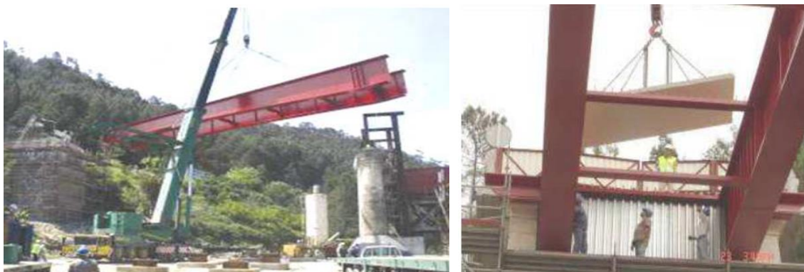
Figura 3.1 – Ponte de Penacova – levantamento da estrutura metálica (esquerda) e aplicação das lajes pré-fabricadas (direita) [W3]
