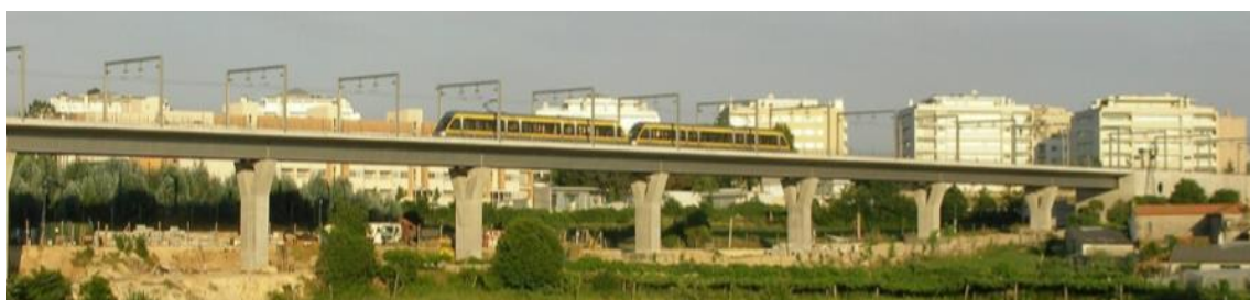
Figura 2.7 - Viaduto da Maia Norte [9] [10]
