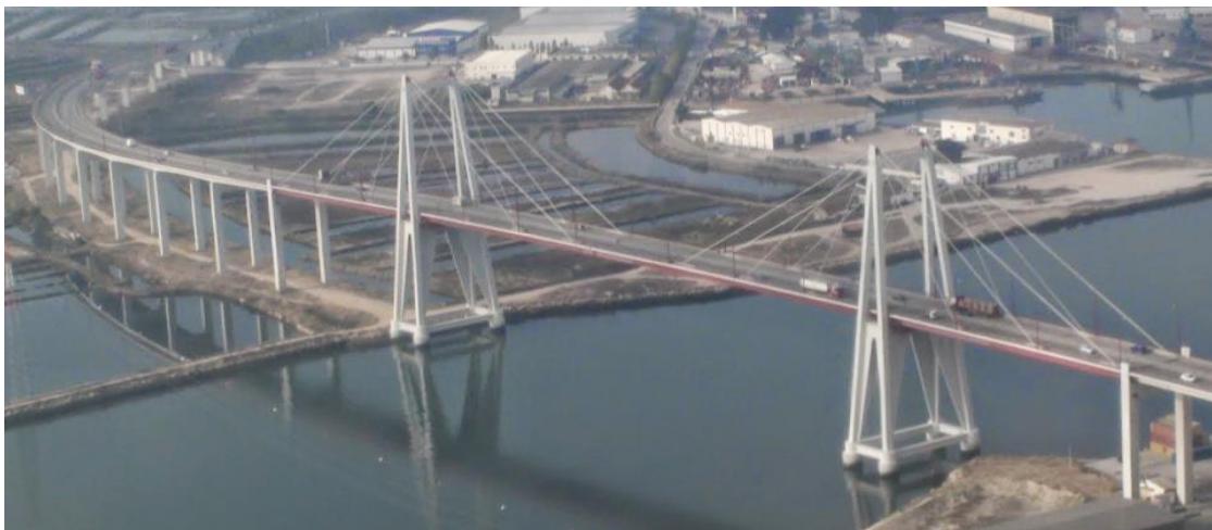
Figura 2.16 – Ponte da Figueira da Foz [W2]
