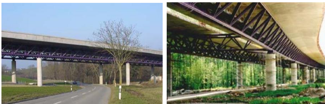
Figura 2.12 – Viaduto de Lully, Suíça[12]
