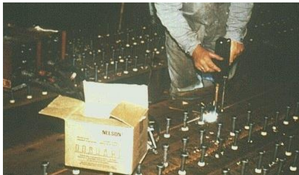
Figura 2.26 - Processo automatizado de incorporação de conectores mediante pistola de solda [W1]
