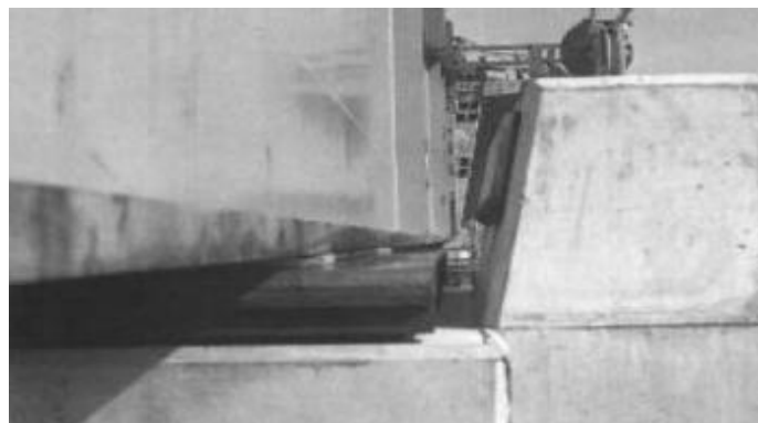
Figura 3.3 - Dispositivo de escorregamento com guia lateral [26]
