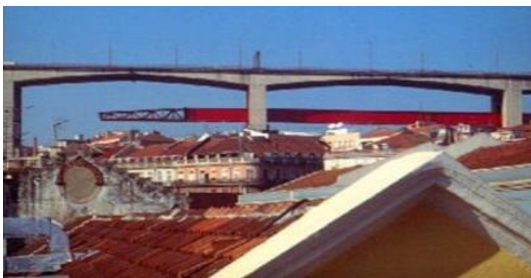
Figura 3.4– Viaduto ferroviário de acesso à ponte 25 de Abril – lançamento do tabuleiro em aço [28]
