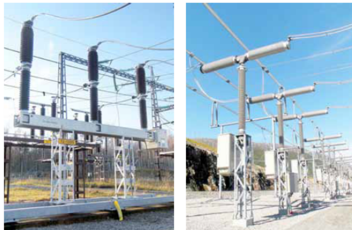
Figura 2.11: Disjuntores SF6 145 kV e 420 kV [3]
