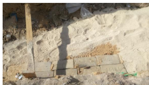
Figura A. IV 4 – Desvio dos serviços EDP, protegidos por areia e blocos de cerâmica?
