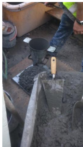
Figura A. IV 6 – Execução do Ensaio de cone ao betão
