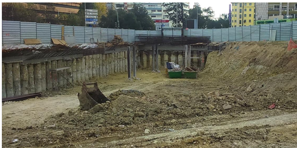
Figura 3.9 Vista do recinto da obra, com alçado BA à esquerda e os perfis metálicos ao centro.
