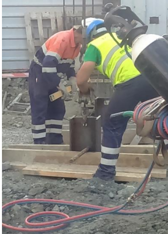
Figura A. IV 13 – Colocação dos perfis metálicos, alçado AB
