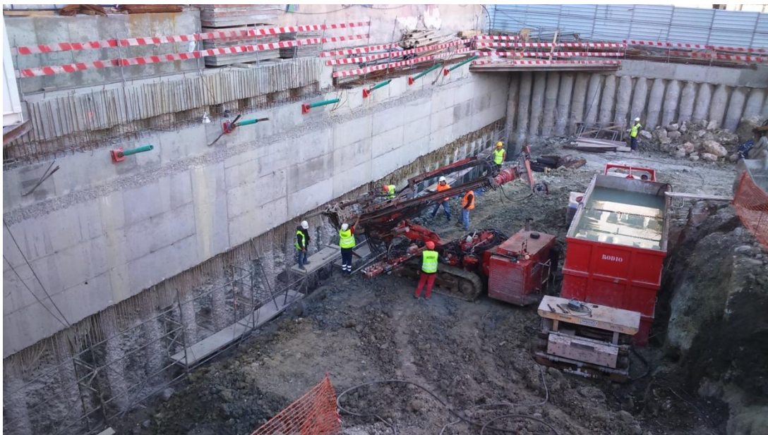
Figura A. IV 23 – Furação com trado para ancoragens de 2º nível do alçado GAI
