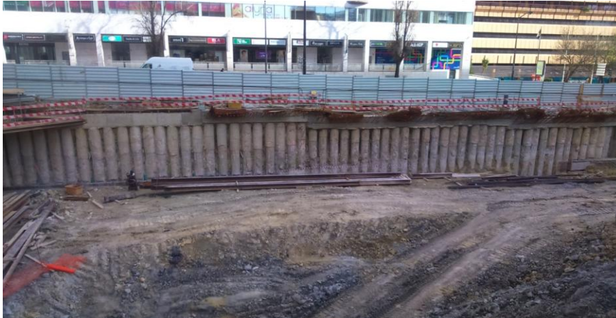
Figura A. IV 32 Vista do alçado AB sem trabalhos a ser executados
