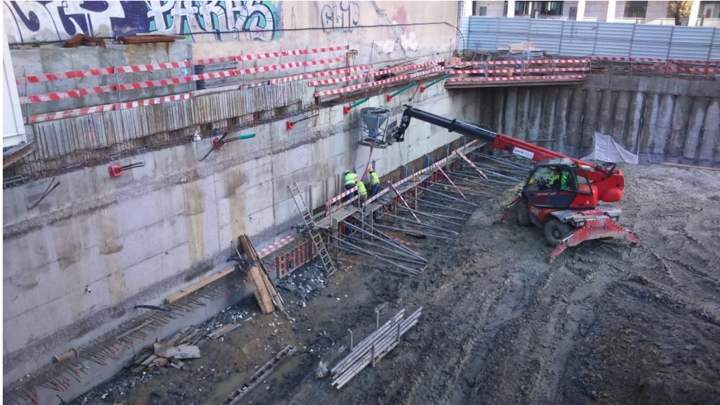
Figura A. IV 28 – Trabalhos de betonagem no alçado GA
