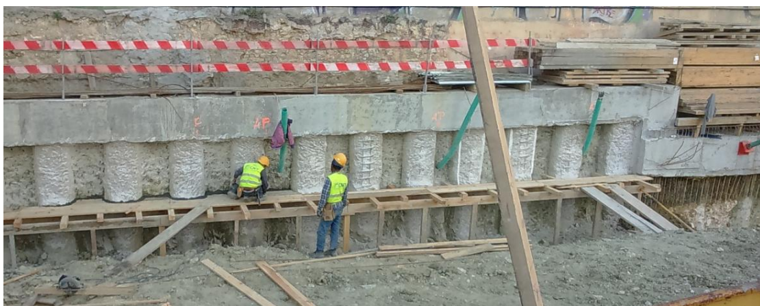
Figura A. IV 15 – Construção da cofragem para viga de distribuição, secção 1 do alçado GA. À esquerda armadura de espera da secção 2
