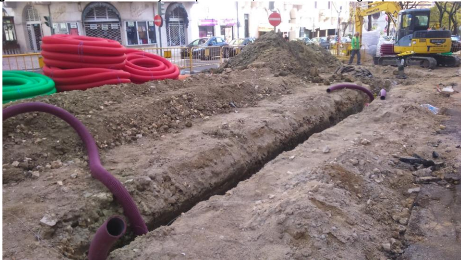
Figura A. IV 34 Trabalhos desvio de serviços na Av. 5 de Outubro.
