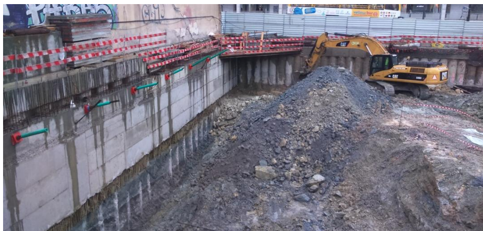
Figura A. IV 21 – Vista do alçado GA, com a parede do nível -1 já construída
