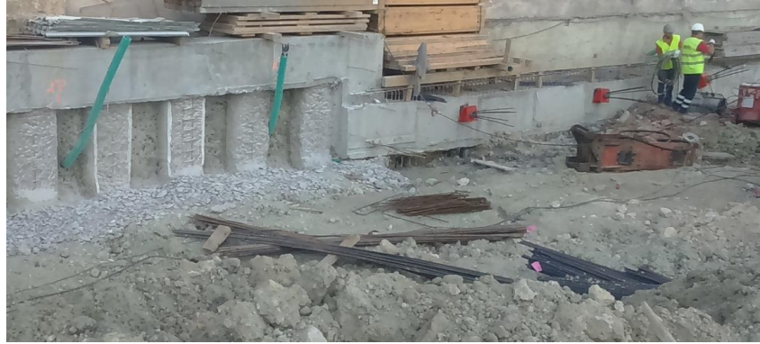
Figura A. IV 14 – À esquerda da imagem encontram-se 2 das ancoragens protegidas com o tubo plástico. À direita, os trabalhadores preparam-se para dar início à instalação do pré-esforço nas ancoragens.
