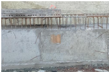
Figura A. IV 9 – Pormenor da marcação do negativo, alçado GA
