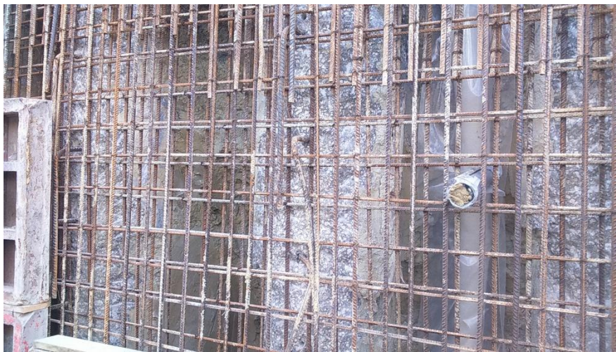
Figura A. IV 31 - Pormenor da armadura e dreno vertical a montante desta no alçado BC
