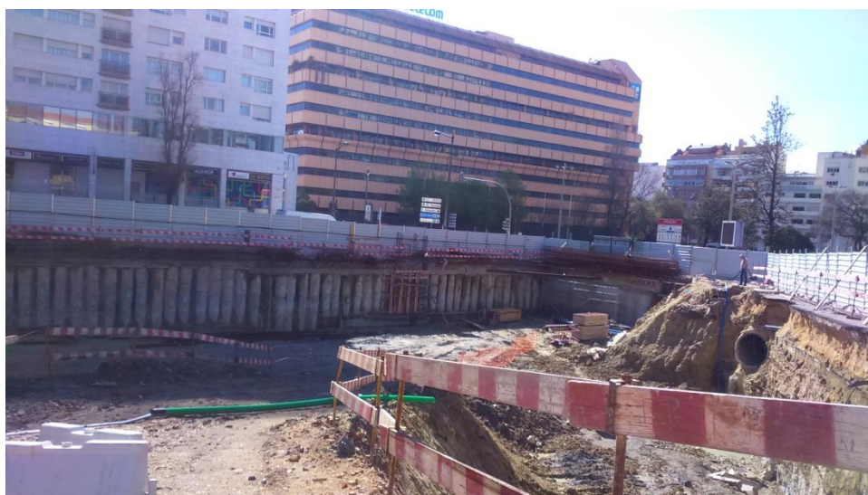
Figura A. I 36 Vista dos trabalhos realizados à data dos alçados AB, BC, CDE.
