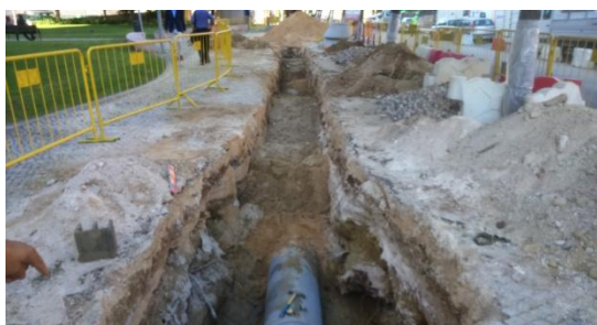
Figura A. IV 5 – Construção do novo Sistema Coletor de Águas Residuais
