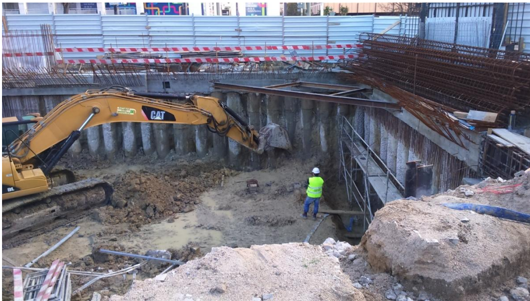
Figura A. IV 27 – Escavação do solo junto do alçado AB e início dos trabalhos na parede do alçado BC
