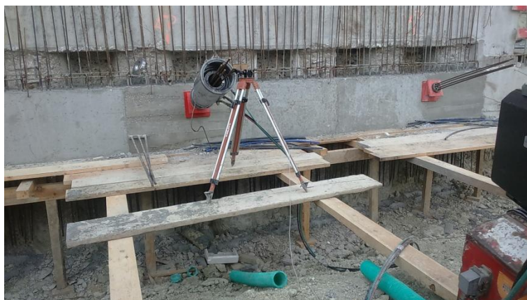
Figura A. IV 20 – Pré - tensão de uma das ancoragens do alçado GA
