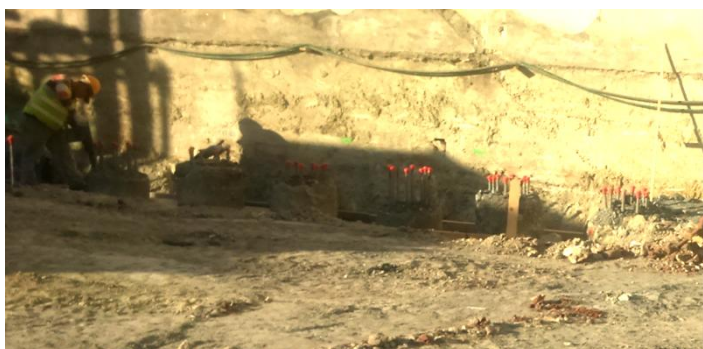
Figura A. IV 1 – Vista da cabeça das estacas do alçado GA
