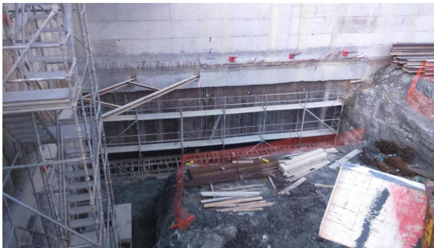
Figura A. IV 33 Vista da construção da parede GA, na zona não abrangida pela banda de laje
