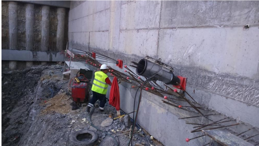
Figura A. IV 30 - Colocação do macaco hidráulico para posterior tensionamento de ancoragens de 2º nível
