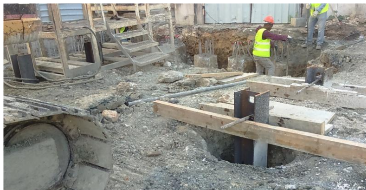
Figura A. IV 16 – Perfis metálicos devidamente protegidos e ao fundo encontram-se trabalhadores a limpar a cabeça de estacas do alçado BC
