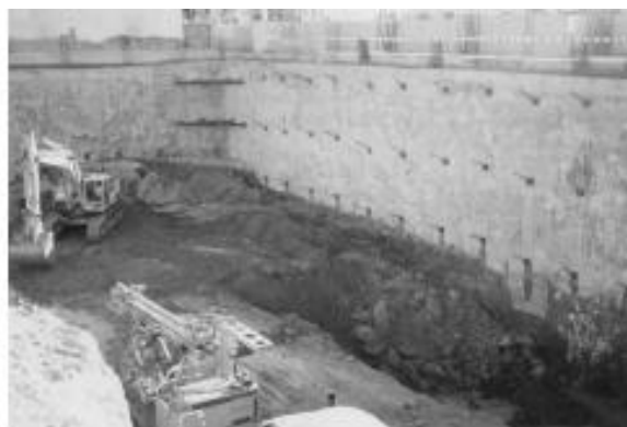
Figura 2.4 Vista da parede moldada, (Cortez, Paredes Moldadas, 2010).
