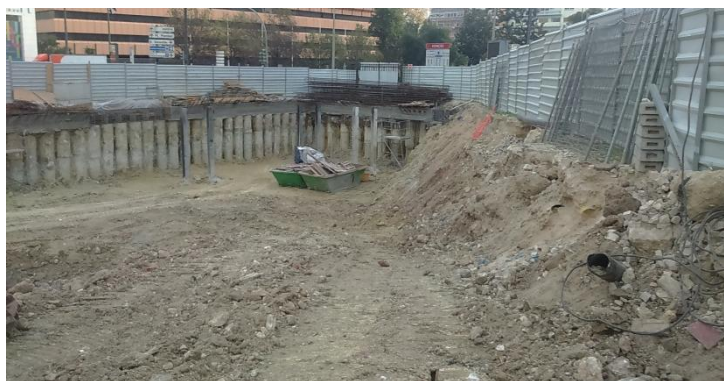
Figura A. IV 19 – Vista da escavação até nível -1 e pormenor do talude que garante a segurança da via pública
