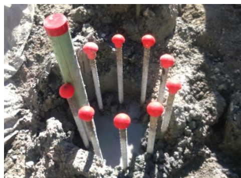
Figura A. IV 8 – Estaca do alçado AB com inclinómetro (tubo verde)
