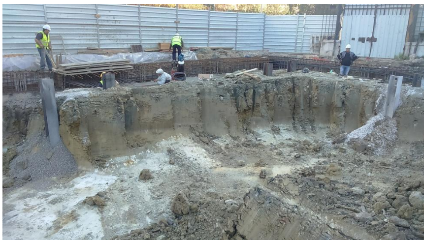
Figura A. IV 18 - Escavação à volta dos perfis metálicos e viga de distribuição dos alçados AB/BC com armadura à vista
