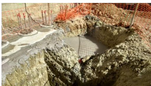
Figura A. IV 3 – Vista do alçado GA, armadura de espera das estacas e poço com água interceptada nas estacas AB
