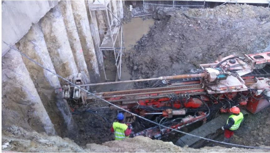
Figura A. IV 26 – Trabalhos de colocação de drenos sub-horizontais no 2º nível no alçado FG
