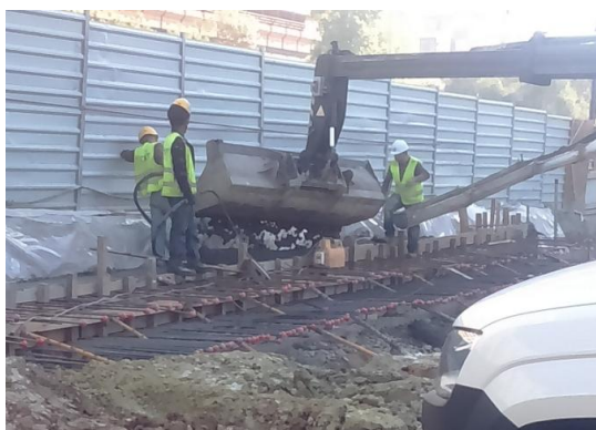
Figura A. IV 11 – Betonagem de 1ª secção do alçado AB
