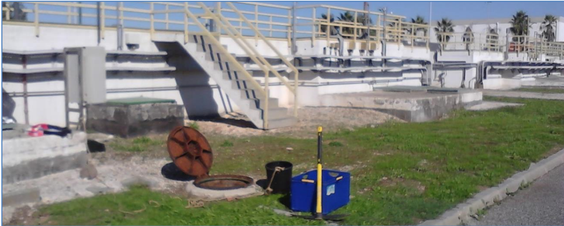
Figura 11 - Câmara de visita utilizada para a recolha das amostras, montante da ETAR de Frielas
