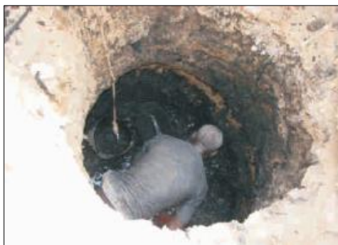
Figura 3.4: Exemplo de recolha manual com indivíduo dentro da fossa, não segura. Retirada de WIN-SA, (2011).
