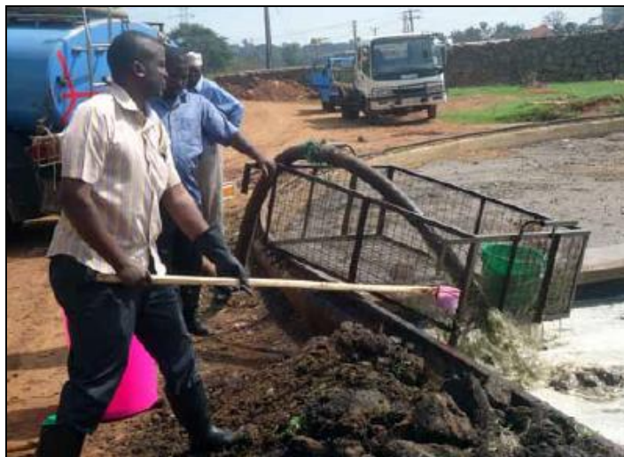
Figura 3.14: Pré-tratamento por gradagem numa estação de tratamento de lamas fecais em Kampala, Uganda. Retirada de Strande et al. (2014).
