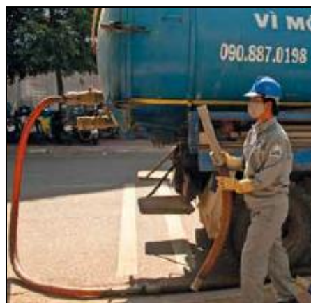
Figura 3.3: Correta proteção e método de coleta mecânica de lamas fecais numa recolha mecânica. Retirada de Strande, et al. (2014).
