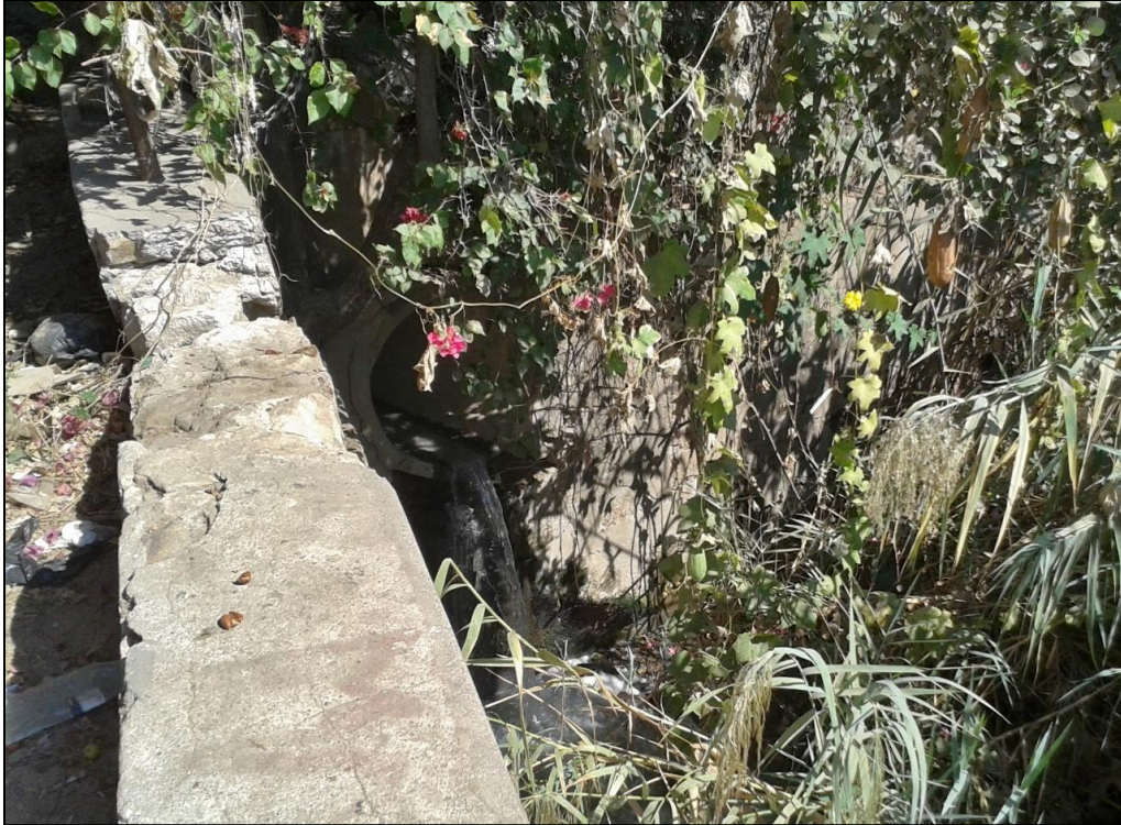
Figura A III: Descarregador do Espaço Urbano da Cidade de Tete.
