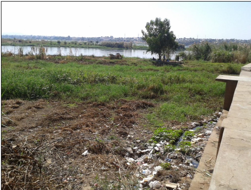
Figura A IV: Vista do descarregador da margem direita do rio Zambeze, junto à ponte do Espaço Urbano.
