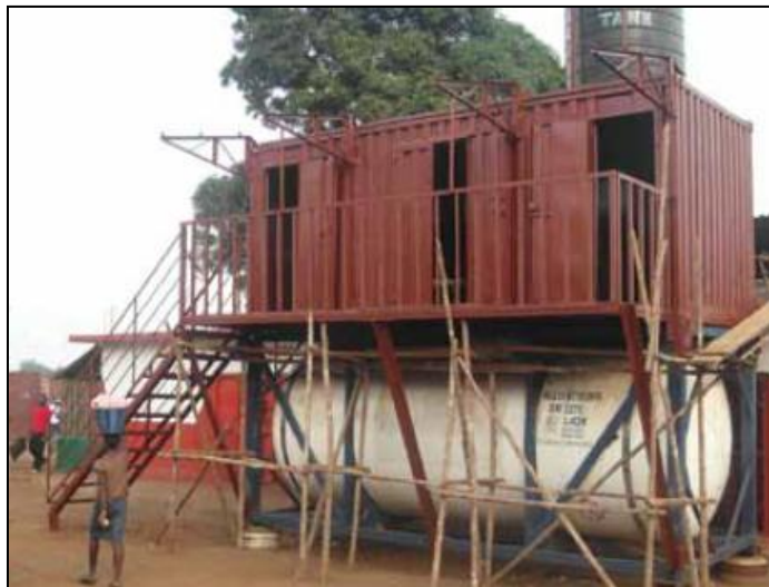
Figura 3.12: Exemplo de estação de transferência móvel com integração de casa de banho pública em Serra Leoa. Retirada de Strande et al. (2014).
