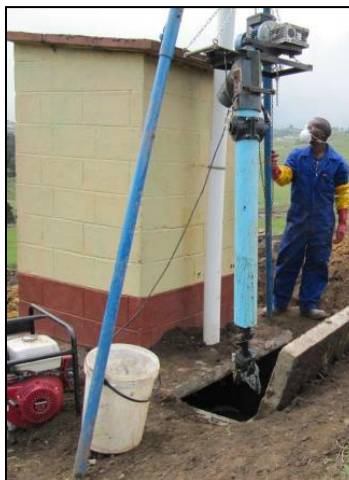
Figura 3.7: Funcionamento de um parafuso motorizado ( 'Pit screw augers' ) com trabalhador com correta proteção pessoal. Retirada de Still & Foxon (2012).
