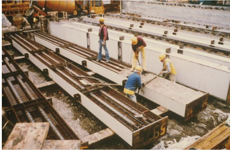
FIGURA 2.9 – EXECUÇÃO DE UMA COLUNA PARCIALMENTE BETONADA, ATRAVÉS DA TÉCNICA APRESENTADA NA FIGURA 2.3
