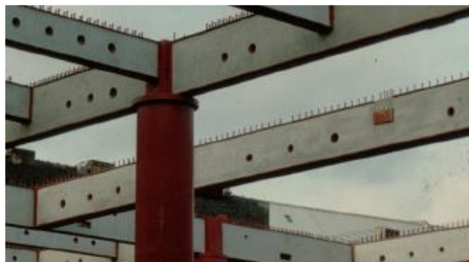
FIGURA 2.12 - PORMENOR DA LIGAÇÃO COLUNA-VIGA
