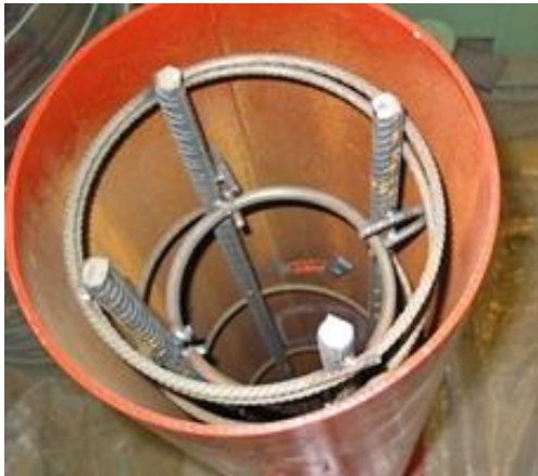
FIGURA 2.11 - COLUNA MISTA DE SECÇÃO CIRCULAR, ANTES DA BETONAGEM
