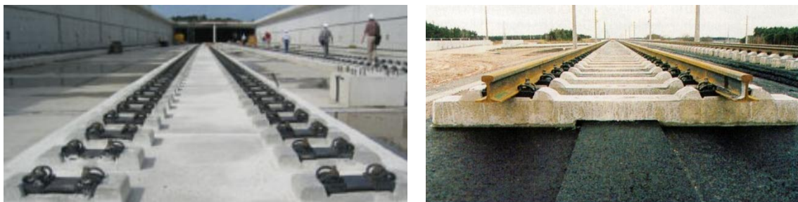
Figura 2.7: CSL (esquerda) e ASL (direita) de vias não balastradas
