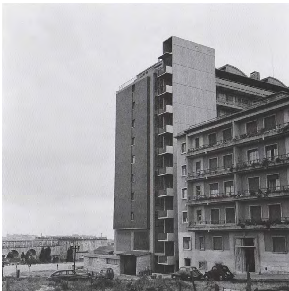
Imagem 13 - Fachada norte, torre de acessos verticais
