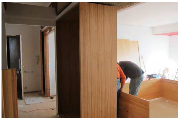
42 – Montagem e posicionamento do novo armário desdobrado;
