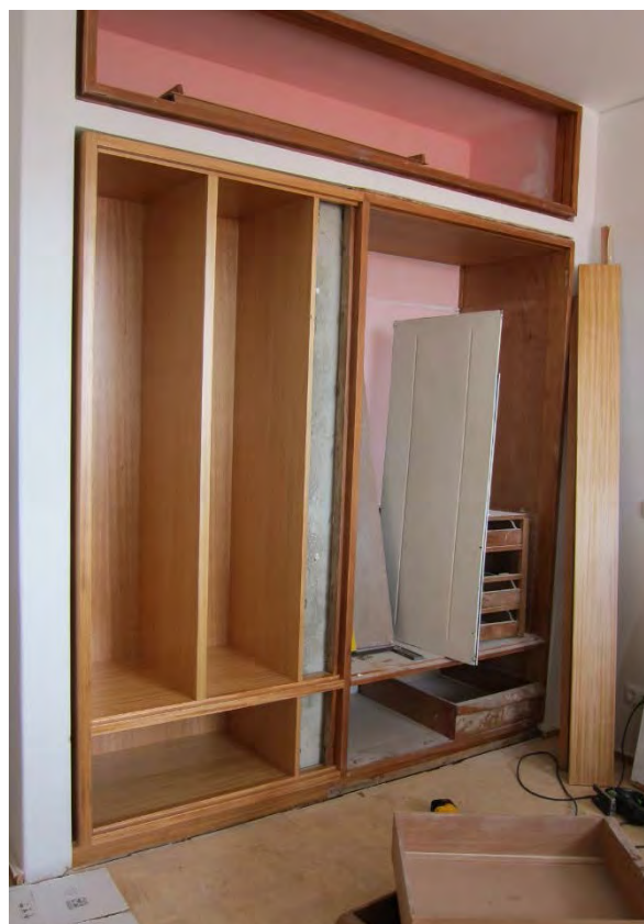
49 – Processo de execução do roupeiro no quarto ampliado;
