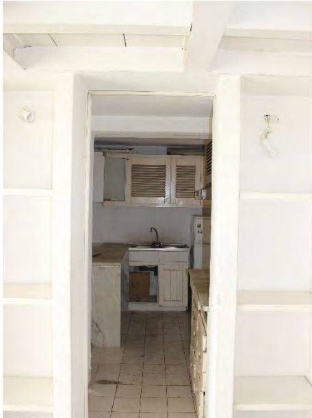
Imagem 72 - Vista sobre o interior da cozinha (Maio, 2012)
