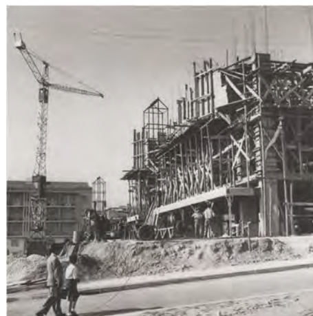
Imagem 18 – Edifício em construção visto da Rua Gorgel do Amaral
