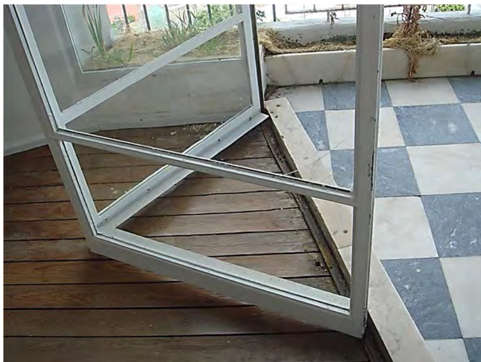
Imagem 31 - Caixilharia metálica do pano envidraçado que estabelece comunicação entre a sala e a varanda pintada a tonalidade branca tal como os restantes caixilhos do apartamento
