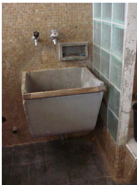
Imagem 35 - Tanque Lava Roupa em Betão moldado tal como se apresentava antes da reabilitação
