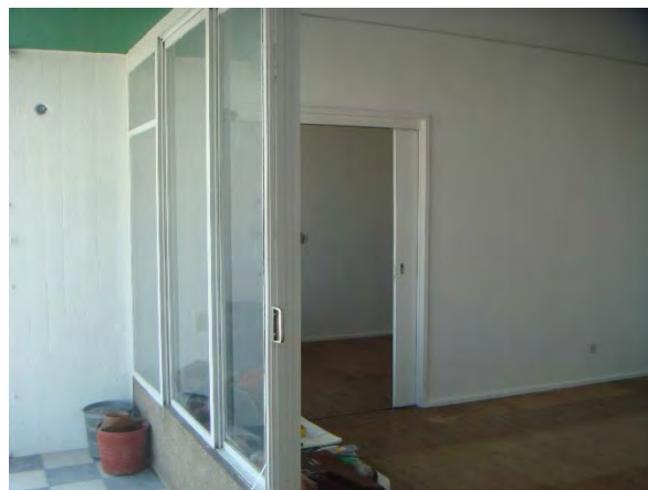
25 – Acesso à varanda;
