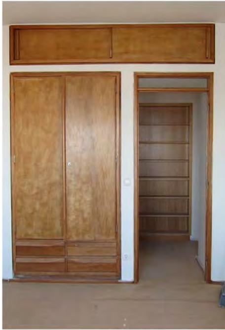
Imagem 44 – Aspecto do roupeiro e da zona de arrumos no sub tecto em madeira de tola restaurada no quarto adjacente à sala comum – após intervenção (Janeiro, 2011)
