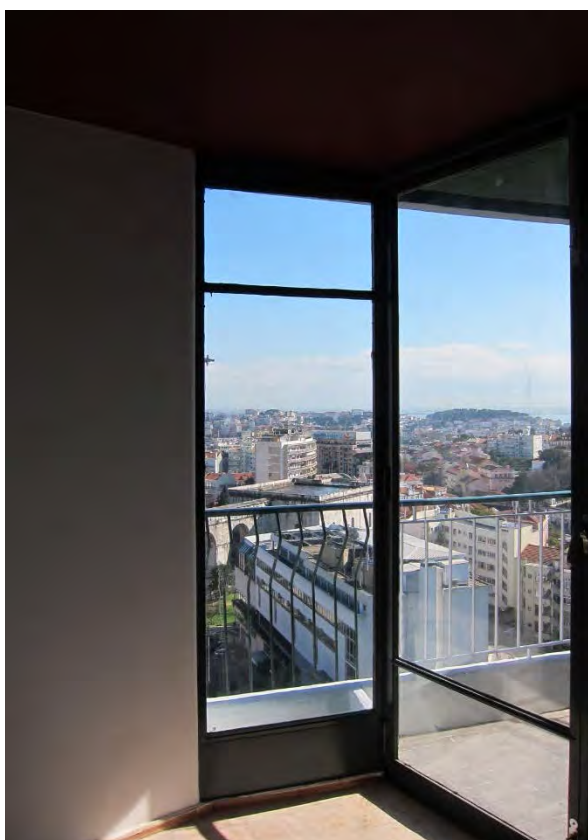
60 – Caixilharias do vão envidraçado na sala após restauro;
