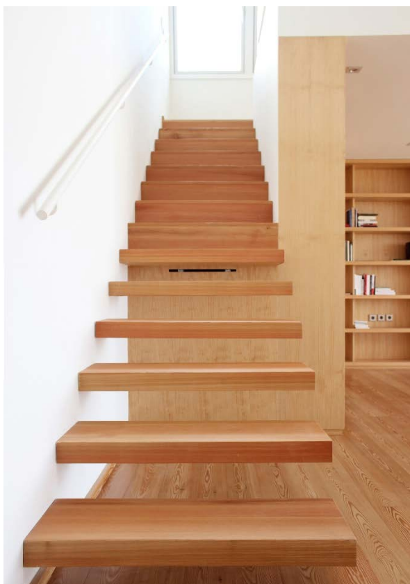
118 – Escada, em degraus “soltos” de acesso ao mezanino;
