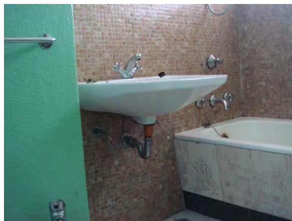
33 – Loças Sanitárias. Revestimento de banheira adicionado;
