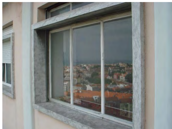
23 – Vão envidraçado no quarto orientado a nascente;
