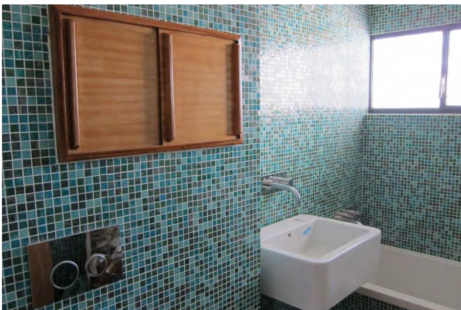
Imagem 46 - Revestimento dos paramentos na instalação sanitária a mosaico vitrificado após intervenção Janeiro, (Janeiro, 2011)
