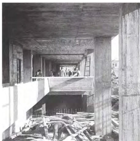
Imagem 15 – Átrio principal do Bloco sobre a Praça das Águas Livres em fase de construção
