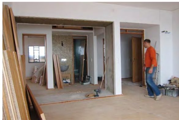
41 – Regularização dos paramentos para introdução de novo armário;
