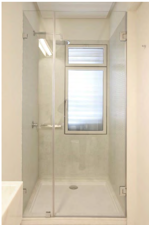
127 – Instalação Sanitária, vista para o duche;
