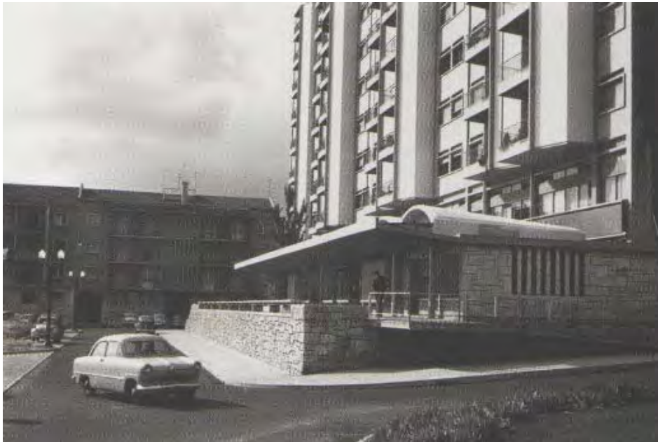
Imagem 14 - Vista sobre o edifício da Rua Gorgel do Amaral, separação evidente entre percurso pedonal e automóvel
