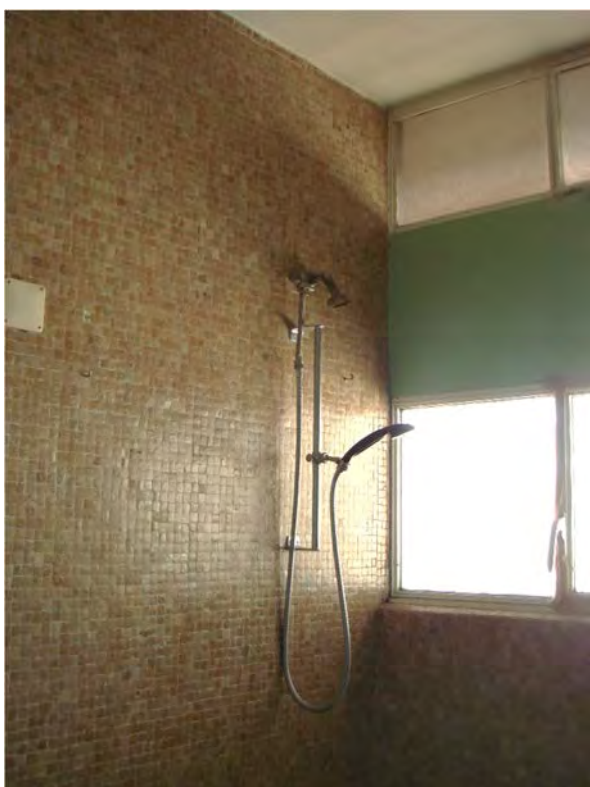
38 – Revestimento do paramento em mosaico vitrificado original;
