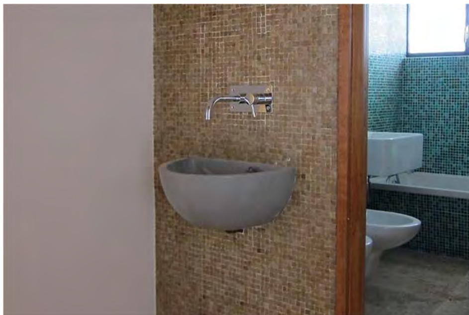
Imagem 47 – Restauro do revestimento do paramento em mosaico vitrificado de tonalidade castanha, redesenho do lava-mãos em betão moldado (Janeiro, 2011)
