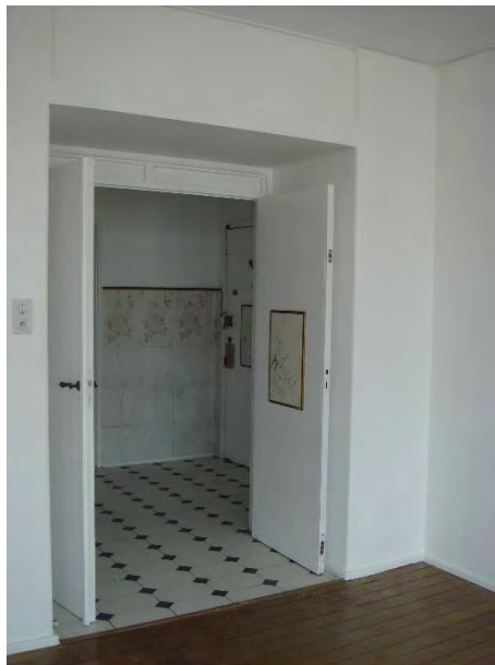
Imagem 29 – Vista da sala sobre o corredor onde foram mudados os revestimentos do pavimento e das paredes. Portas a madeira de tola originais pintadas a tonalidade branca;
