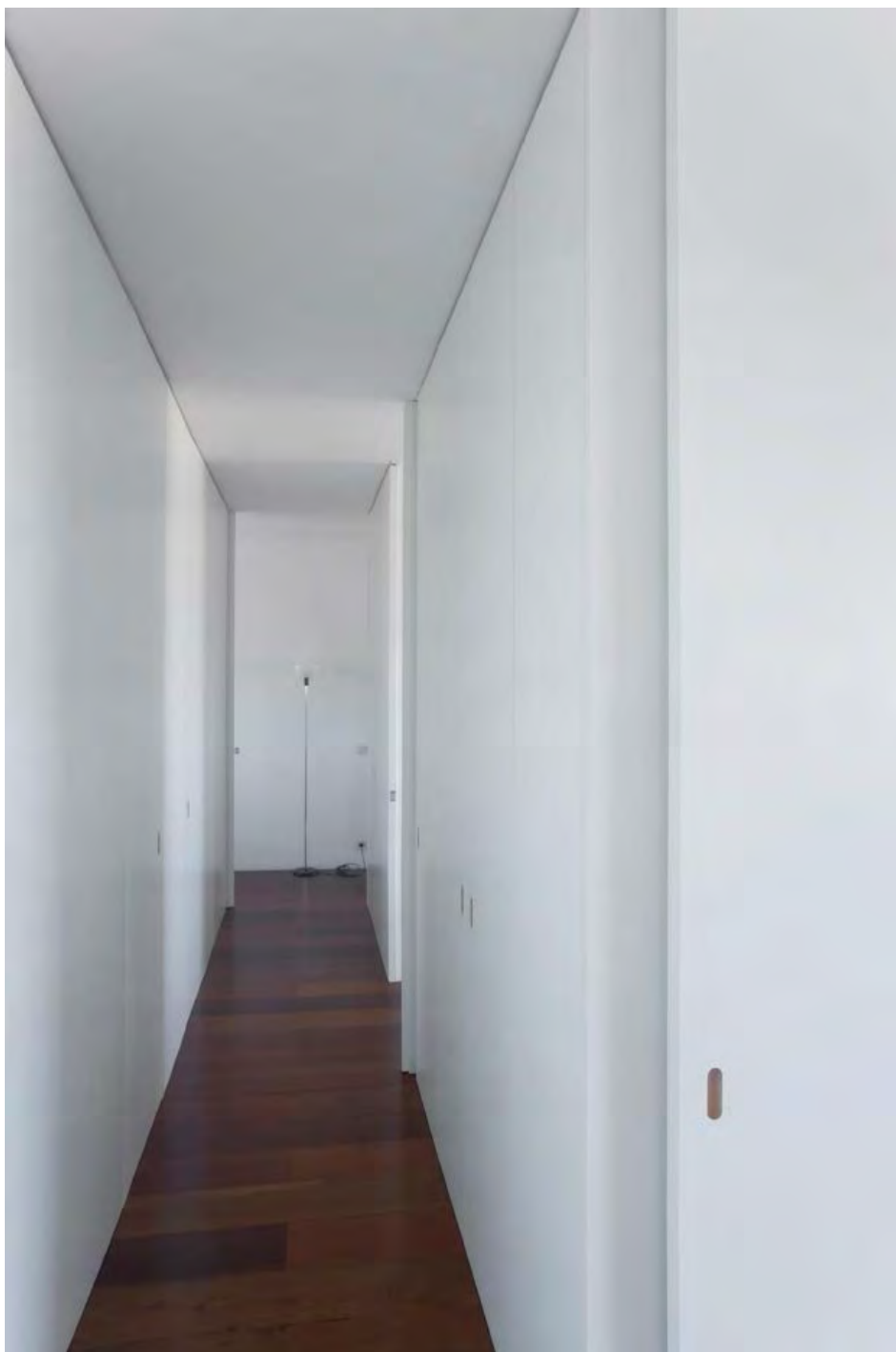
Imagem 58 – Corredor de circulação interior, pavimento em soalho de madeira ipê e uniformidade visual entre a solução de revestimento dos suportes verticais e tecto e os módulos pré-fabricados em madeira, após intervenção (Dezembro, 2007)
