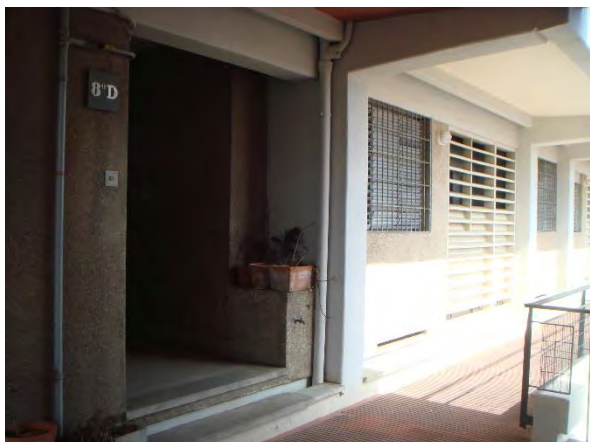
22 – Área exterior na galeria de serviço comum;
