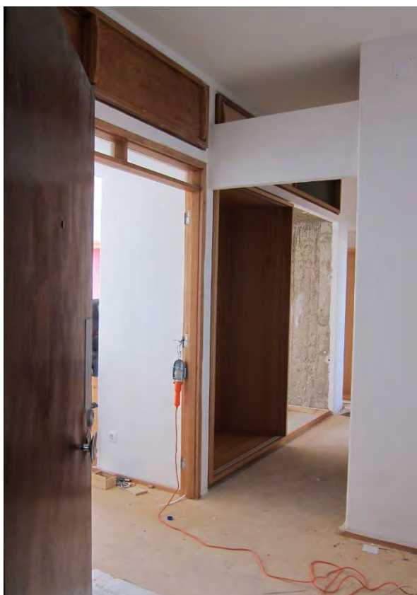
48 – Entrada do apartamento, construção do novo armário na transição do corredor para a sala;
