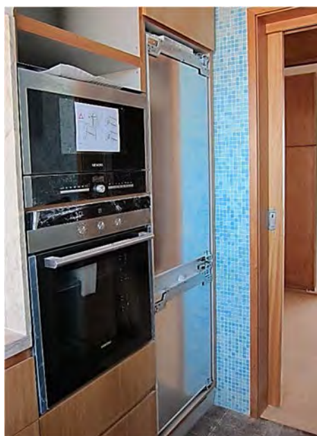
Imagem 36 – Electrodomésticos embutidos nas estruturas de armários: frigorífico, forno e micro-ondas, (Janeiro, 2011)
