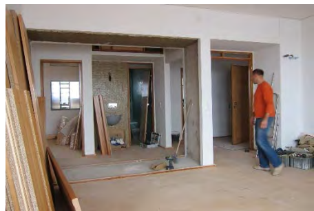
Imagem 40 – Regularização dos paramentos para posterior introdução de armário desdobrado (Janeiro, 2011)
