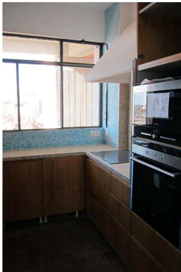
59 – Cozinha do apartamento, armários em MDF hidrófugo lacado;
