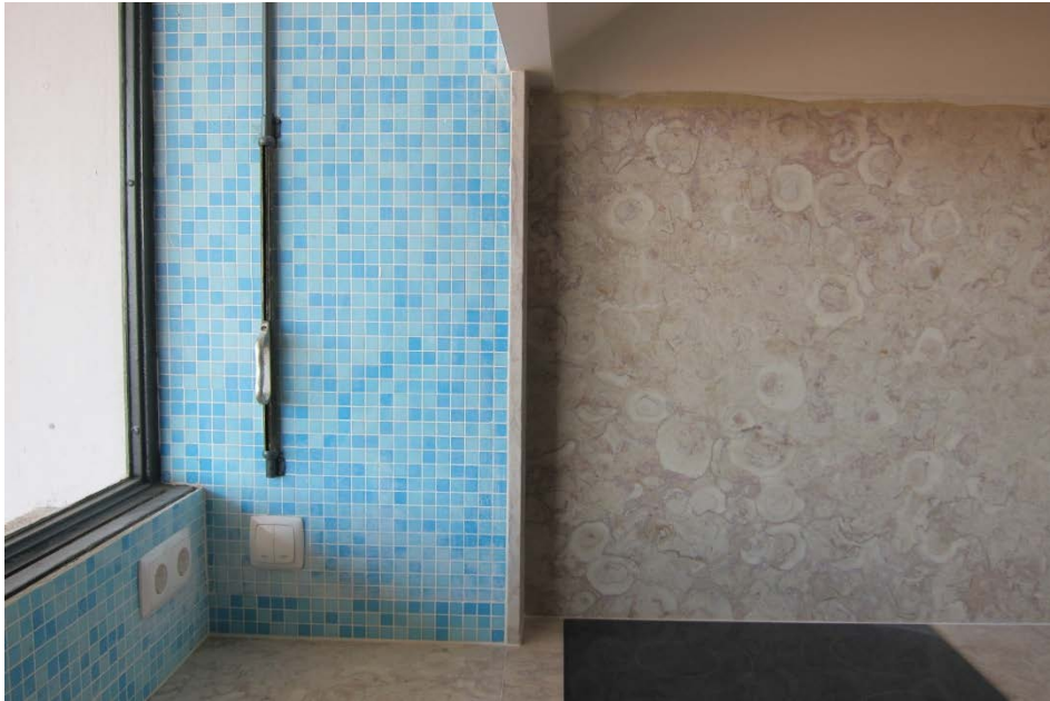
Imagem 48 - Pormenor do mosaico vitrificado (cor azul água) aplicado na cozinha; Tampo de bancada e frente de fogão (vitrocerâmica) em pedra Lioz polida – após intervenção (Janeiro, 2011)
