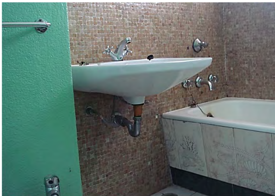
Imagem 30 - Instalação sanitária com paramentos revestidos a mosaico vitrificado originais. Adição de mosaicos com padrão no revestimento da banheira e pintura de paramentos a tonalidade verde
