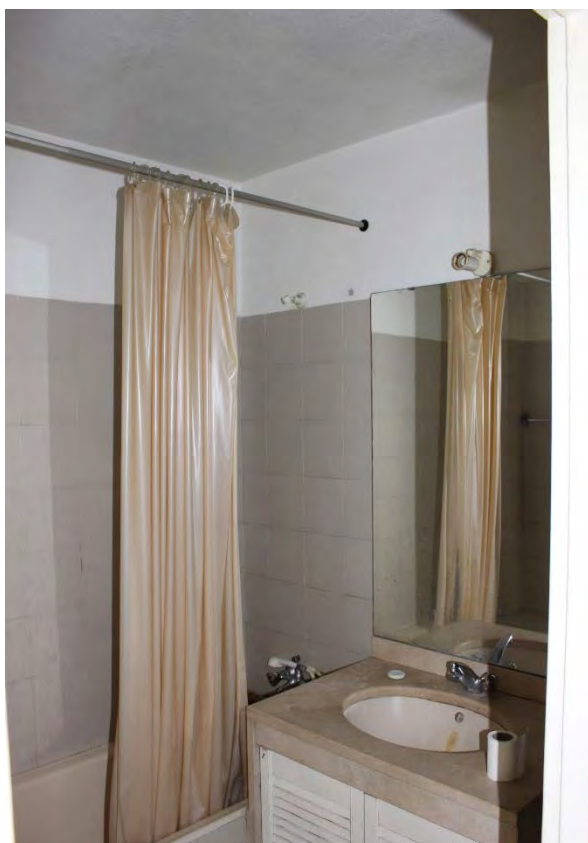
109 – Interior da instalação sanitária acrescentada;
