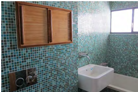
56 – Revestimento dos paramentos na I.S. em mosaico vitrificado;
