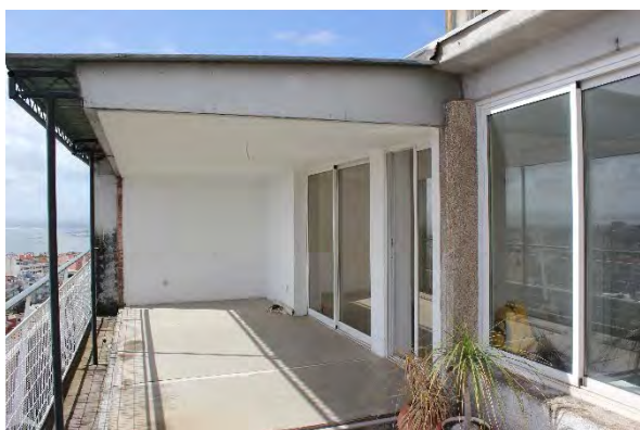
103 – Terraço, adição de alpendre em estrutura metálica;
