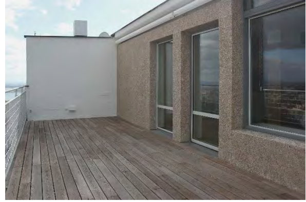
121 – Espaço exterior, paramentos revestidos a marmorite;
