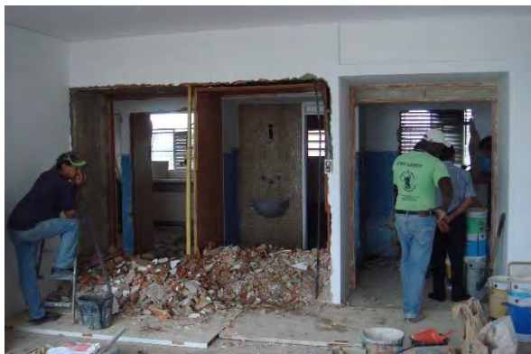
40 – Demolição da parede divisória e armário orientado para corredor
