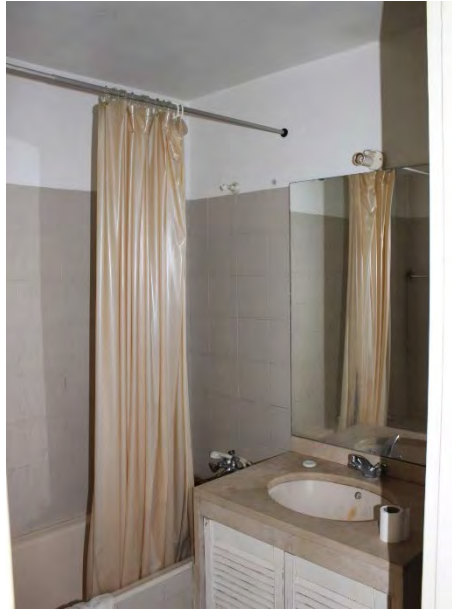
Imagem 73 - Interior da Instalação Sanitária (Maio, 2012)
