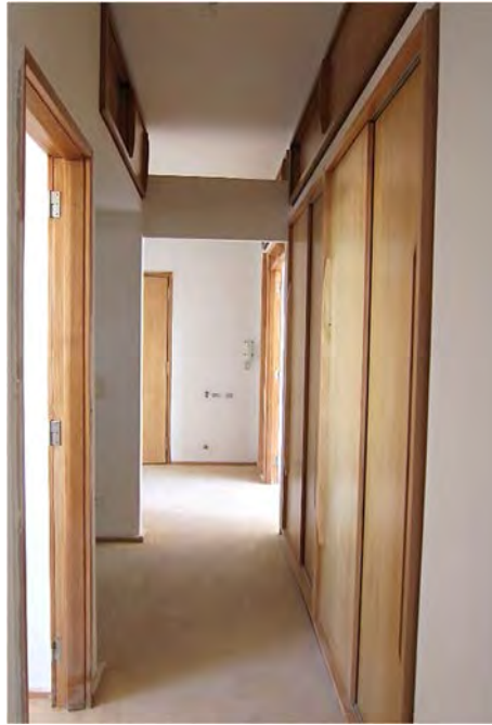
Imagem 45 – Componentes em madeira no corredor. Anota-se a criação do novo armário que se desdobra em estante para a sala comum, recriando o desenho original em madeira de tola (Janeiro, 2011);
