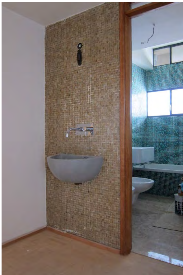
58 – Paramento do vestibulo após restauro do mosaico vitrificado e restabelecimento do lava-mãos em betão moldado;
