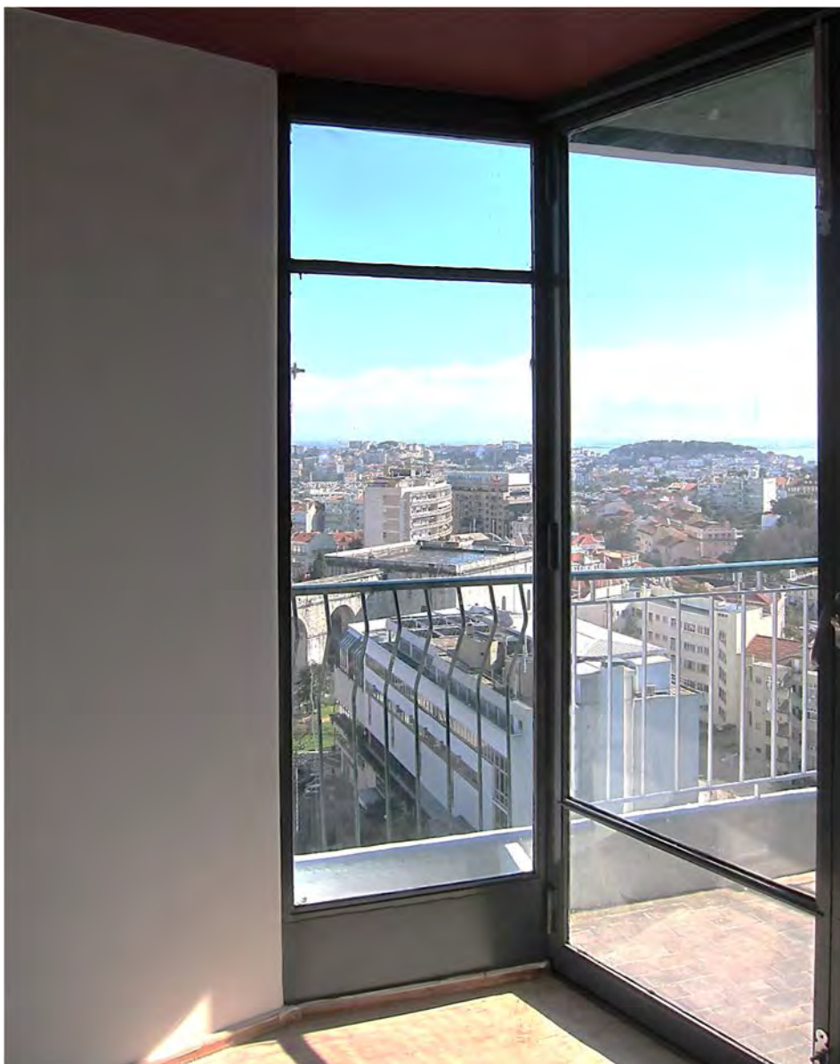
Imagem 42 - Caixilharias do vão envidraçado presente na sala após intervenção, (Janeiro 2011)
