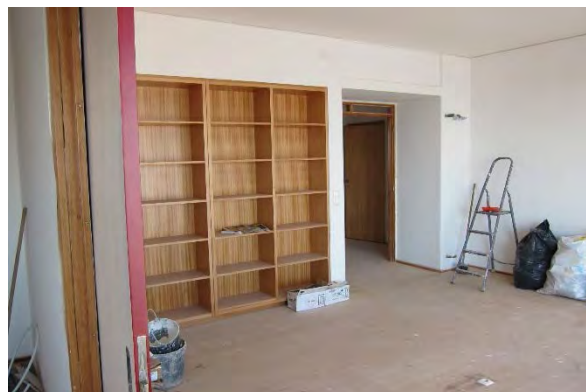
47 - Sala do apartamento ainda em fase de acabamentos;
