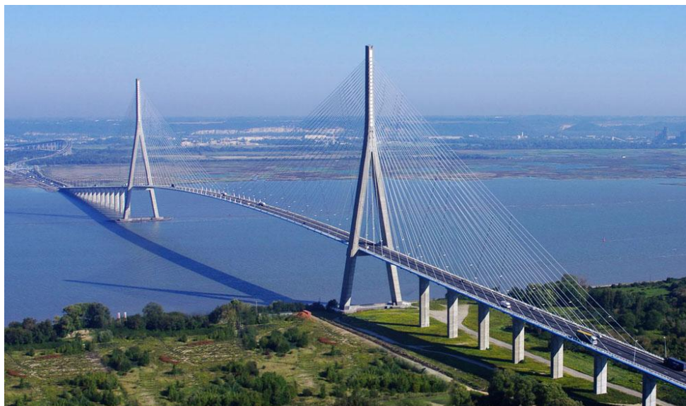
Figura 13 - Ponte da Normandia (N4)
