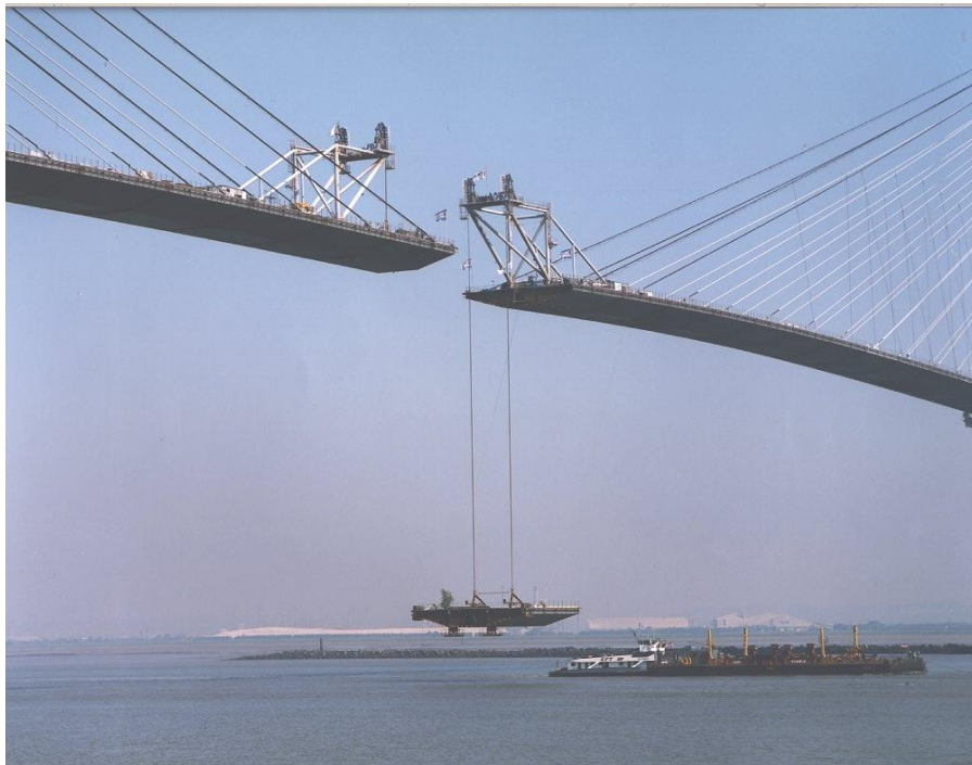
Figura 15 - TMD localizado na extremidade do tabuleiro em construção (N6)
