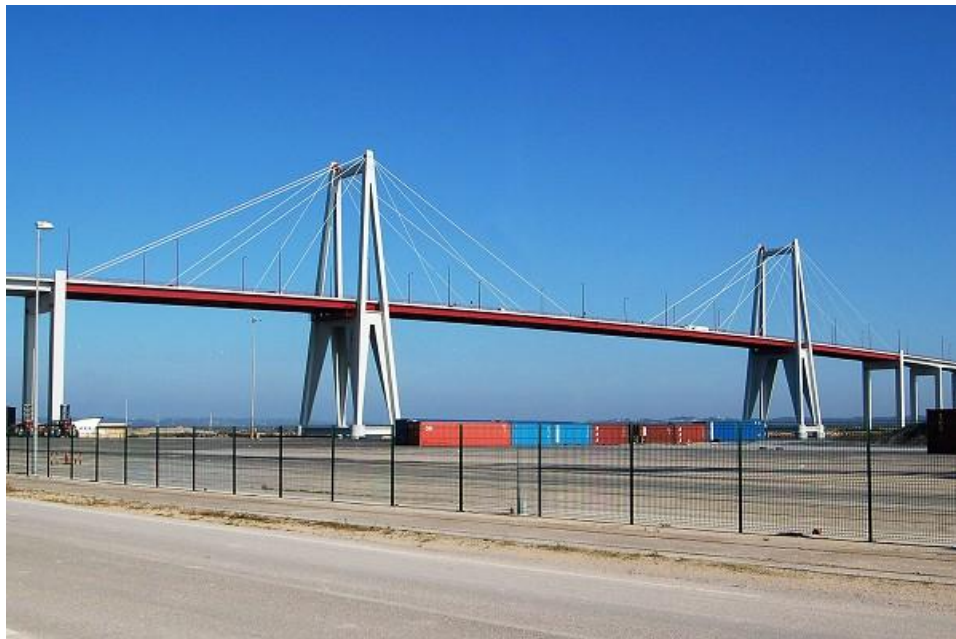
Figura 3 - Ponte de tirantes da Figueira da Foz (N1)
