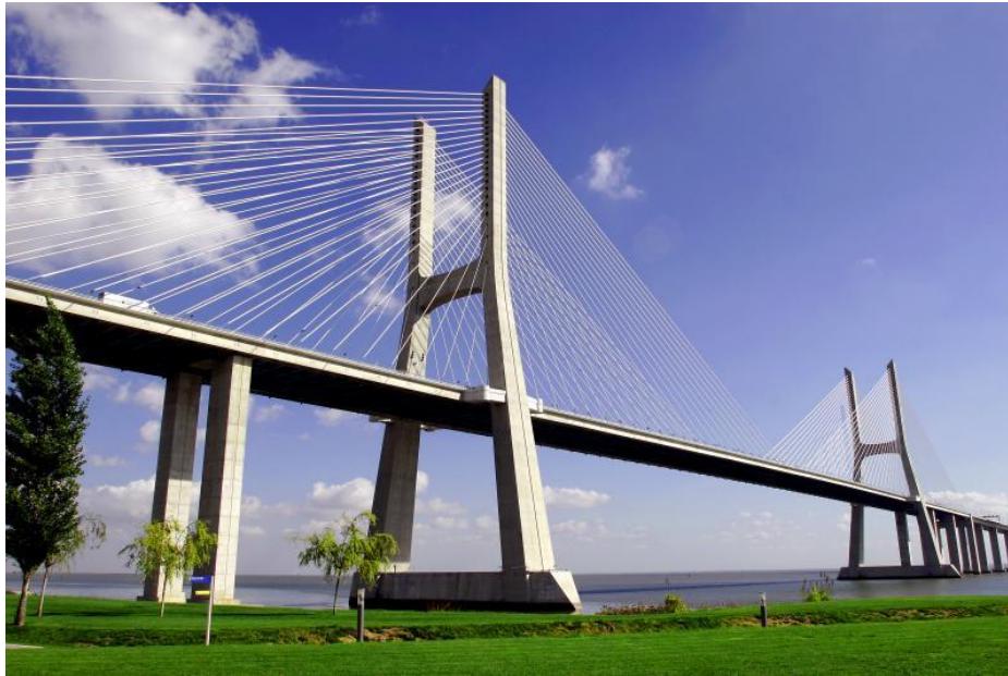
Figura 10 - Ponte Vasco da Gama (N3)
