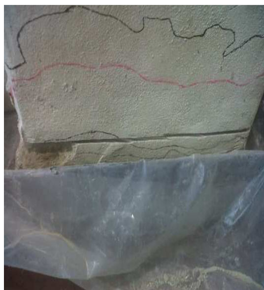
Figura 3.30 – Corte efetuado com rebarbadora.
