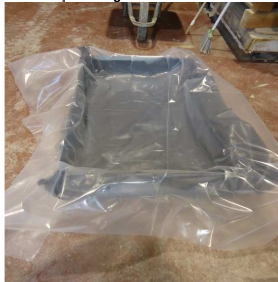
Figura 3.8 – Preparação da base de suporte para construção do murete de alvenaria.
