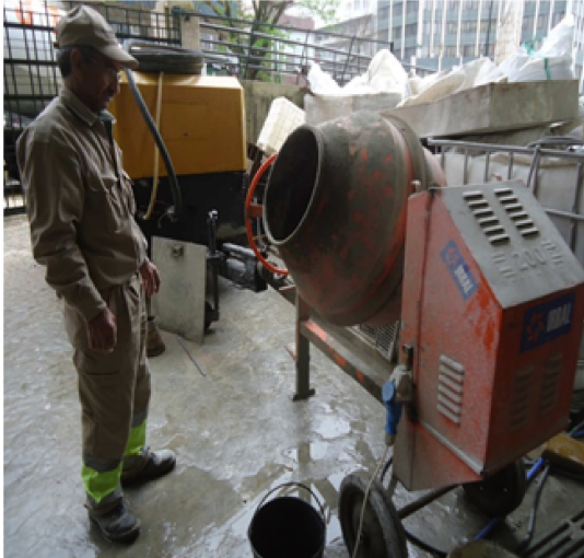
Figura 3.25 – Controlo da amassadura da argamassa.
