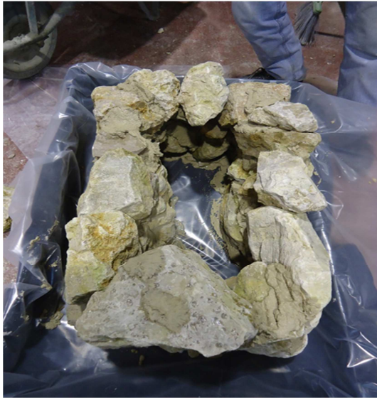
Figura 3.11 – Segunda fiada de alvenaria.
