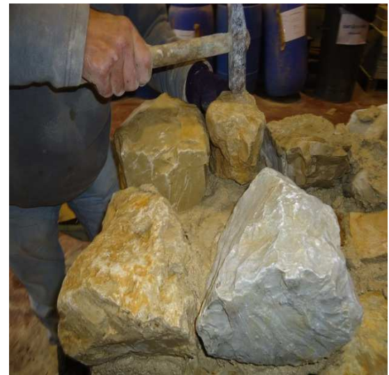
Figura 3.14 – Ação com martelo para garantir bom encaixe da pedra e o refluir da argamassa.
