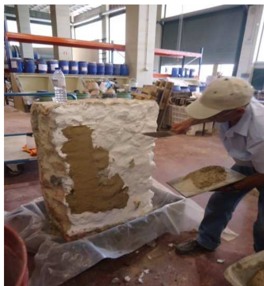
Figura 3.40 – Aplicação de camada de reboco com dente na base da face “B”.
