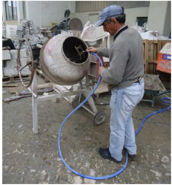
Figura 3.6 – Lavagem da betoneira para execução de argamassa.
