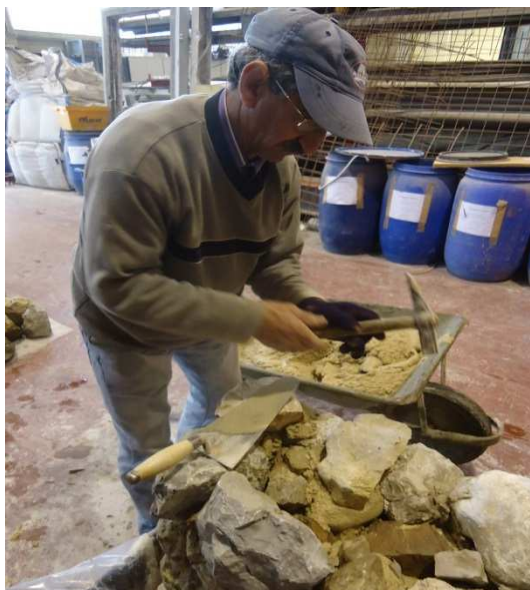
Figura 3.15 – Preenchimento interior.
