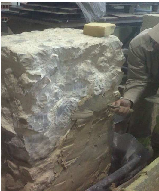
Figura 3.27 – Aplicação de argamassa.
