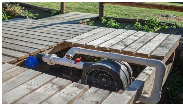
Figura 62 – Hidroturbina da QM – PSML
