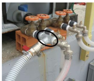
Figura 4.9 - Solução adoptada para vaziar o volume total do tanque intermédio
