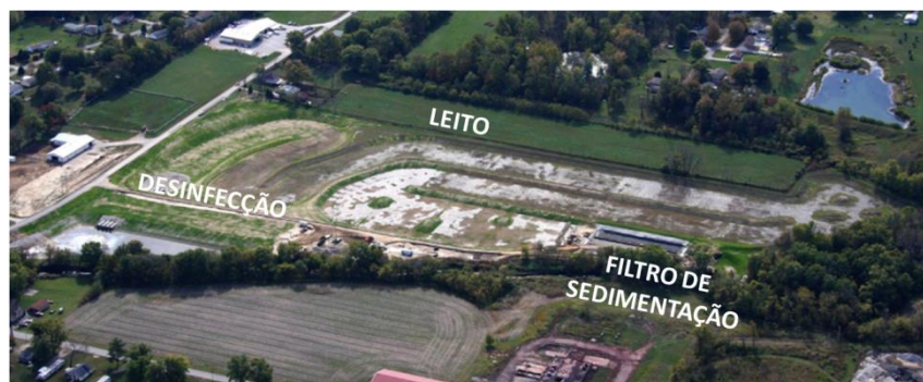
Figura 2.10 - Estação de tratamento natural em Washington, Indiana (adaptado de Bernardin Lochmueller & Associates, 2013)
