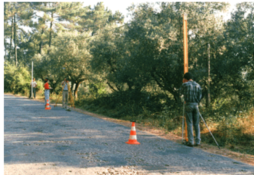
Operação de nivelamento geométrico
