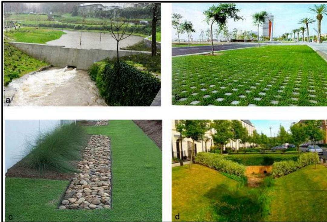
Figura 1.1 – a)Bacia de retenção (fonte: CMG 2016); b)Pavimentos com estrutura de reservatório (fonte: docplayer 2008 ); c)Trincheiras de infiltração (fonte: aquafluxus 2012 ); d)Valas com cobertura vegetal (fonte: azulnews 2019 )
