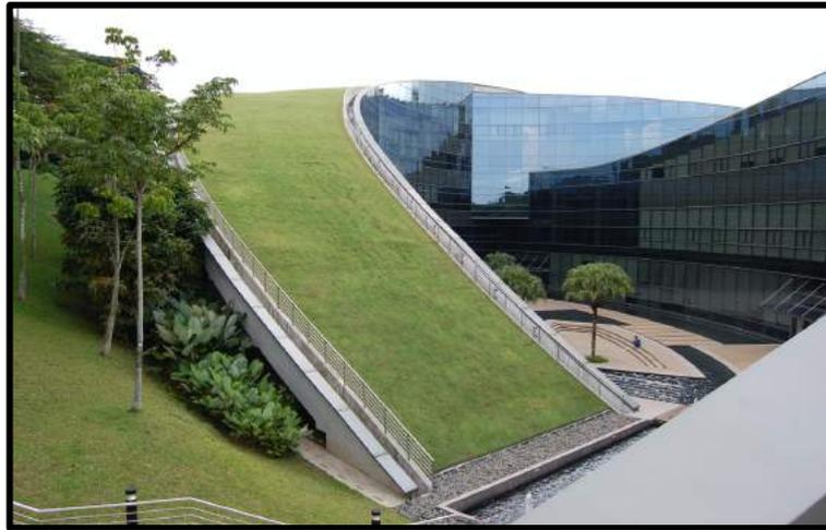
*Figura 2.2 - Cobertura verde com inclinação significativa (fonte: Diprotec 2016)*
