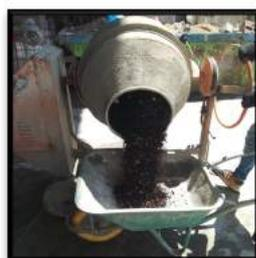
Figura 4.7 – Mistura dos agregados com o substrato técnico
