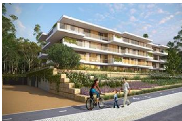
Figura 42 - Imagem do edifício de dois blocos de apartamentos em avaliação, (Grupo André Jordan, 2019).
