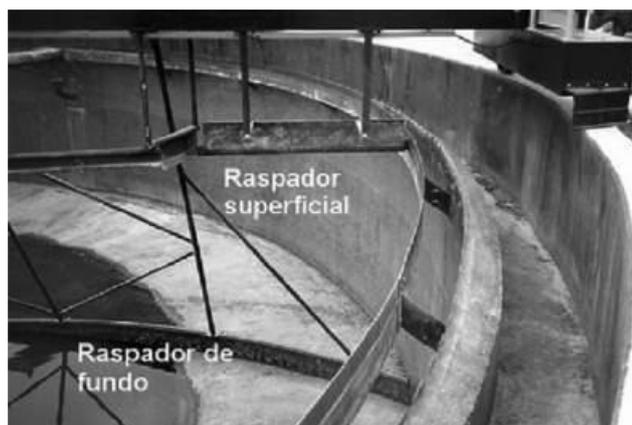
Figura 23 - Ponte raspadora de um decantador [29].
