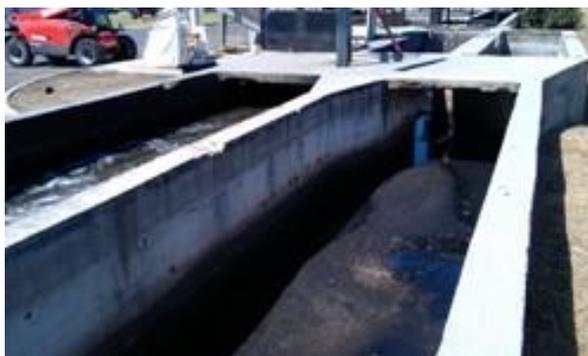
Figura 17 – Exemplo de canal aberto em obra de entrada, fornecido por AdP.
