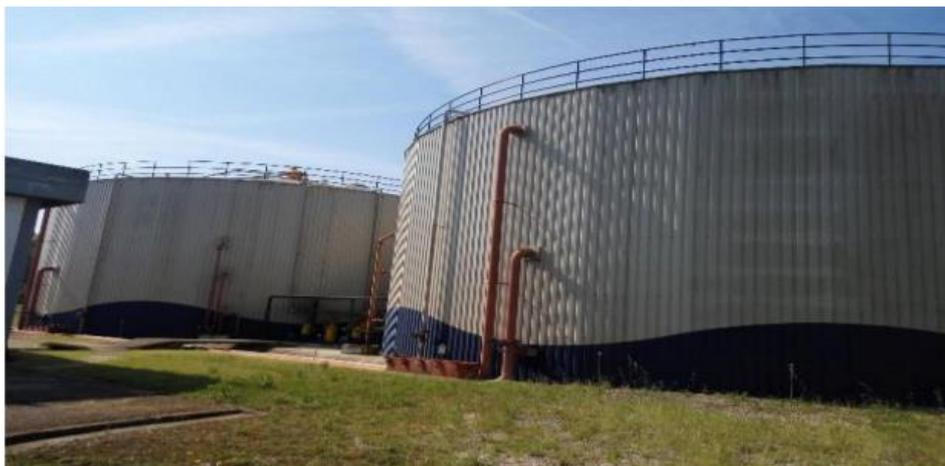
Figura 26 - Digestores anaeróbios da ETAR do Choupal [36].
