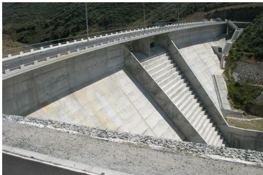
Figura 29 - Descarregador de cheias sobre a barragem – Barragem das Olgas [25].
