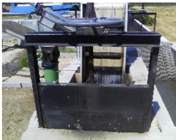
Figura 18 – Exemplo de válvula de comporta de canal de entrada, fornecido por AdP.
