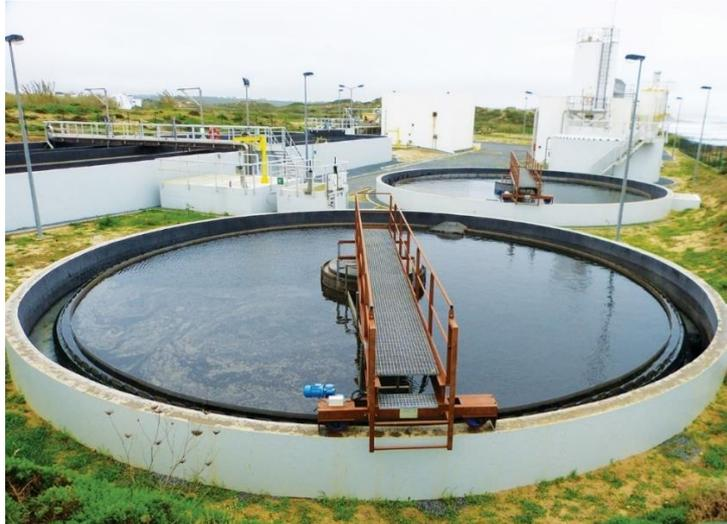
Figura 22 - Decantador circular [32].
