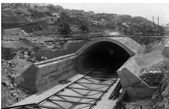
a) Construção do caneiro de Alcântara – Obras de cobertura da ribeira de Alcântara
