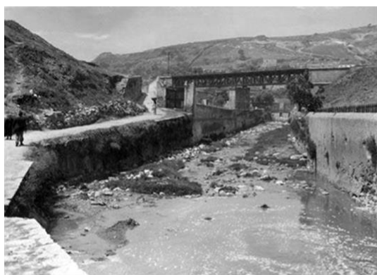
a) Ribeira de Alcântara junto ao viaduto da linha de caminho de ferro.
