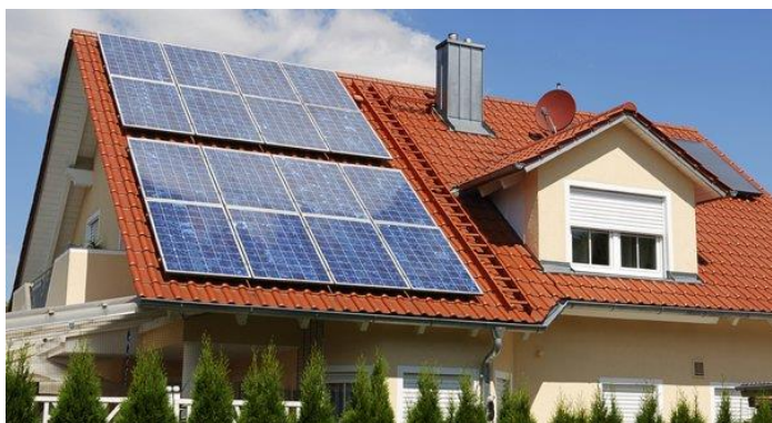
Figura 3-1: Habitação com painéis FV instalados no telhado [20].
