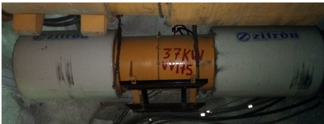
Figura 1.1: Fotografia de um ventilador secundário de 37kW em funcionamento, equipado com dois silenciadores posicionados anterior- e posteriormente, de forma a minimizar o ruído emitido pela movimentação das pás do rotor.
