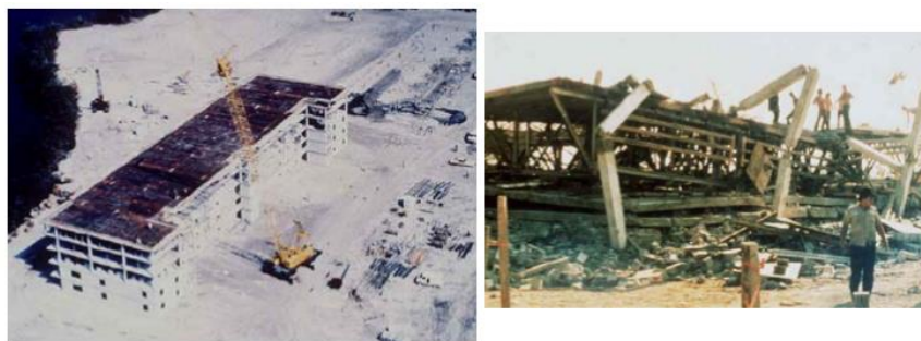
Figura 2.6 Harbour Cay Condominium antes do colapso e após o colapso [9]
