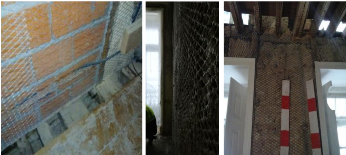
Figura 32 - Pormenores das malhas de aço distendido aplicada nas diversas paredes (imagens disponibilizadas pela Enescoord).
