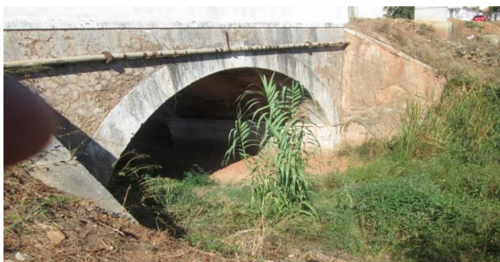
Figura 25 - Aspeto geral da ponte sobre a Ribeira da Machada antes da intervenção (imagem disponibilizada pela H Tecnic).
