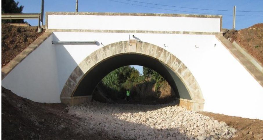
Figura 28- Aspeto final da Ponte sobre a Ribeira da Machada (imagem disponibilizada pela H Tecnic).
