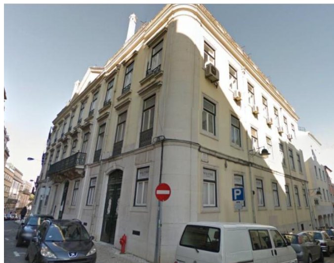
Figura 31 – Fachada do edifício da Rua da Salitre, Nº 134, 136, 136ª, 138 (Google Maps ®).
