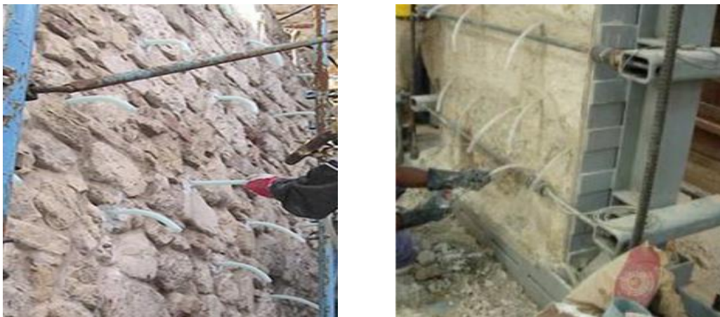
Figura 8 – Injeção de caldas sob pressão (Almeida et al., 2011).
