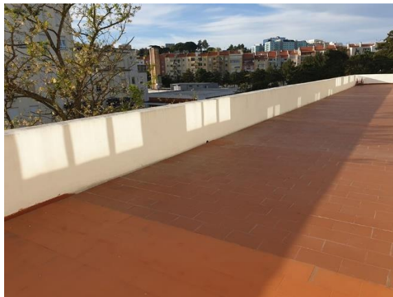
Figura 3.9 - Cobertura do edifício.
