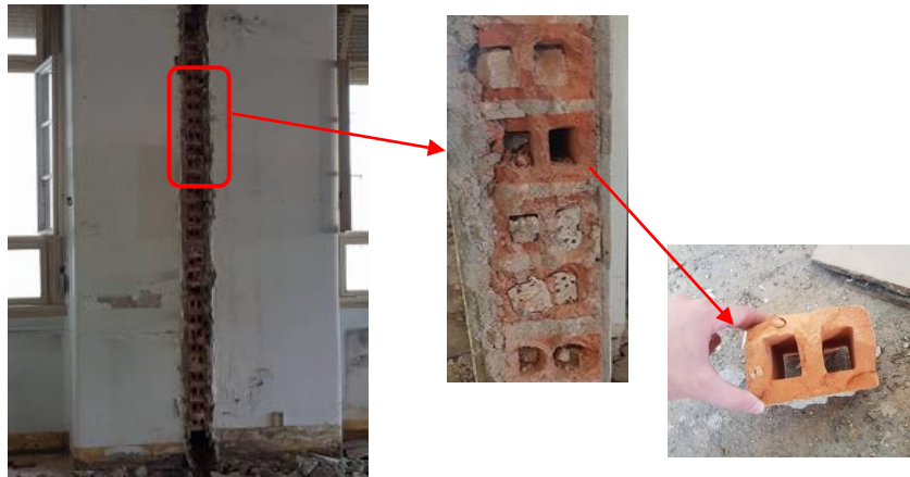
Figura 3.8 - Pormenor da solução construtiva da parede divisória.
