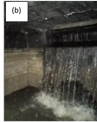
Figura 2.3.6 – (a) Ponto de descarga no Rio Tejo, com válvula de maré a montante (David e Barroso, 2017) e (b) Câmara de válvula de maré do descarregador representado na figura à esquerda (David e Barroso, 2017)
