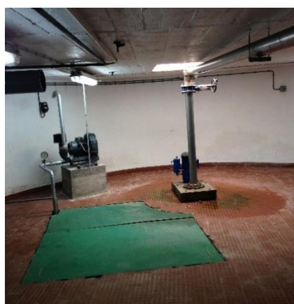
Figura A.3- Zona do desarenador no interior da EE do Jamor
