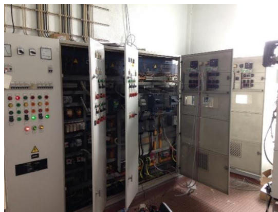
Figura A.2- Painéis de controlo da EE do Jamor
