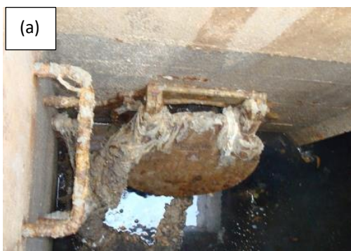
Figura 2.3.7 – (a) Deficiente estado de conservação de uma válvula de maré para descarga de emergência de uma EE (Soares et al. ) e (b) Câmara de visita situada a montante de uma EE apresentando várias ligações à rede de drenagem (lado esquerdo), sendo que uma delas corresponde a uma abertura por corrosão do betão onde se
