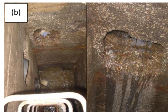
Figura 2.3.7 – (a) Deficiente estado de conservação de uma válvula de maré para descarga de emergência de uma EE (Soares et al. ) e (b) Câmara de visita situada a montante de uma EE apresentando várias ligações à rede de drenagem (lado esquerdo), sendo que uma delas corresponde a uma abertura por corrosão do betão onde se
