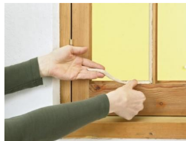
Figura 2.5 - Aplicação de massa de vidraceiro (DiyNetwork, 2017)
