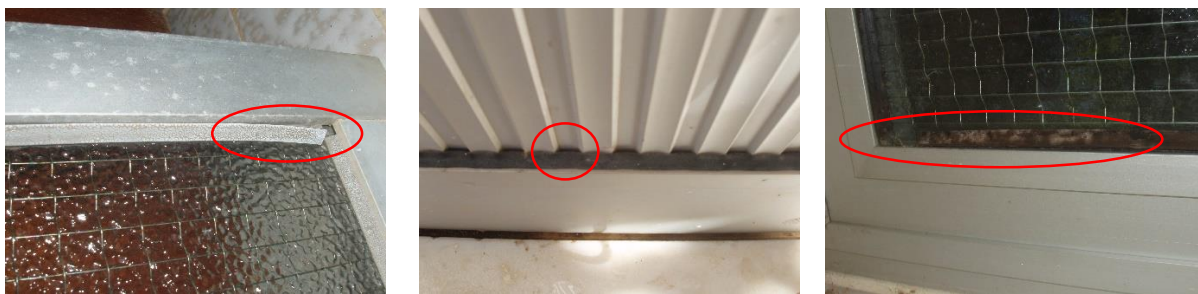
Figura 2.9 - Início do descolamento do vedante (à esquerda), incorrecta vedação (ao centro) e colonização biológica (à direita)
