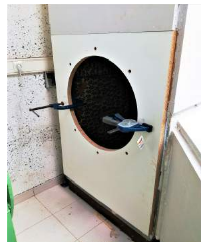
(b) Nova porta de fixação da turbina.
