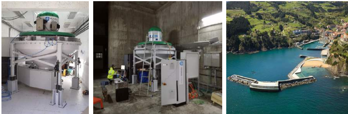
(a) Turbina bi-radial na instalação V-Flow antes de ser transportada para o Mutriku (retirado de [19]). (b) Turbina bi-radial em funcionamento no quebra-mar do Mutriku (retirado de [19]). (c) Quebra-mar do Mutriku com instalações de CAO (retirado de [24]).
