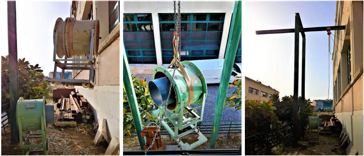
(a) Transporte das diferentes condutas da turbina. (b) Içamento de uma secção da conduta da turbina. (c) Carretel, correntes e grua de içamento da turbina.
