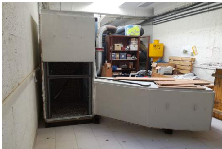
(a) Local de fixação da turbina à câmara de pleno.
