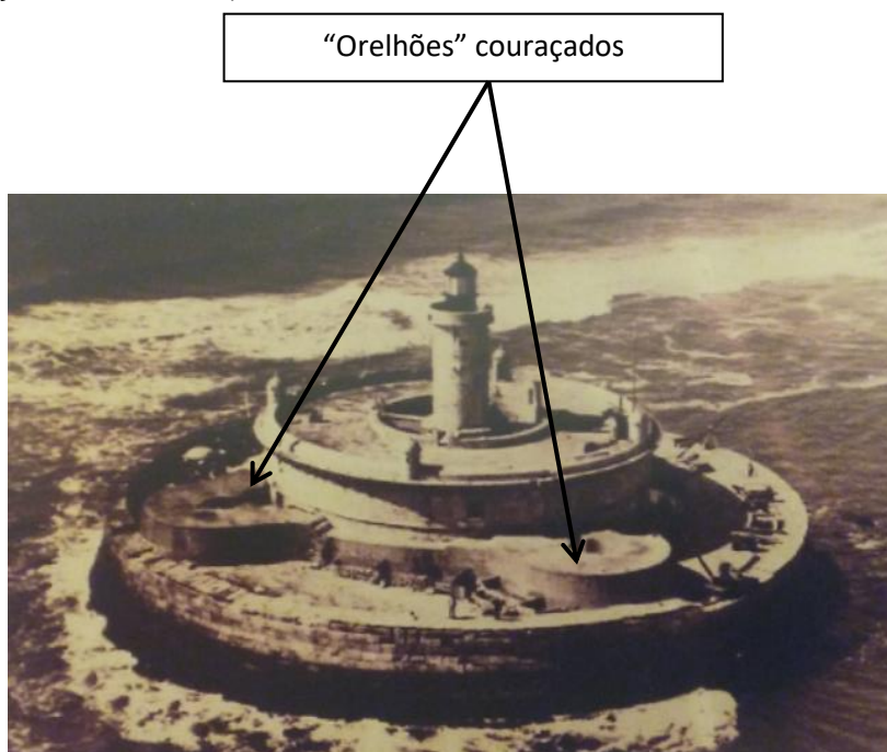
Figura 12: O forte e o farol nos anos 30 do século XX onde são visíveis duas estruturas couraçadas: “orelhões” na bateria baixa, adaptado de (Boiça & Barros, 2004)
