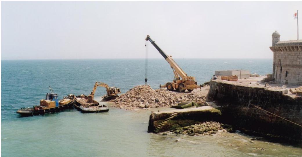
Figura 18: Transporte e colocação da primeira camada de enrocamento no molhe circundante ao Forte do Bugio, 1998. Fotos cedidas pelo Eng.º Lopes de Castro.
