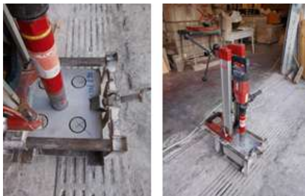
Figura 4.19 - Carotagem dos provetes para o ensaio de "Pull-off".
