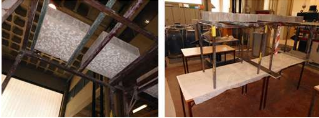
Figura 4.11 - Estrutura para aplicação das argamassas em tecto.
