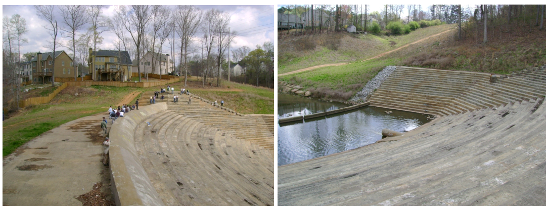
Figura 1.2: Barragem de Yellow River Watershed No 14, Georgia, EUA, construída em aterro em 1967, reabilitada em 2004 (Fot.: Jorge Matos).
