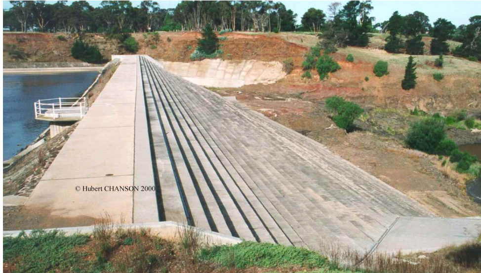
Figura 1.3: Barragem de Melton, Austrália, construída em aterro em 1916, reabilitada em 1994 (Fot.: Chanson, 2000).
