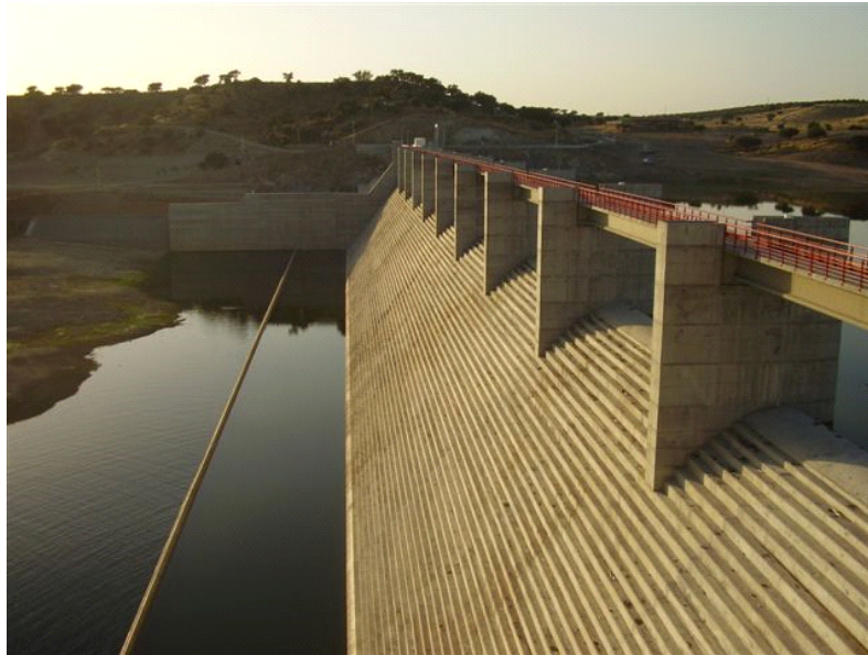
Figura 1.1: Barragem de Pedrógão (Fot.: Jorge Matos).
