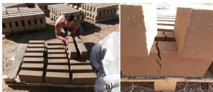
Figura 31 – Cura dos blocos a) Colocação dos blocos para cura. b) Pormenor de erro de colocação e demonstração da reduzida resistência à tração dos blocos frescos.
