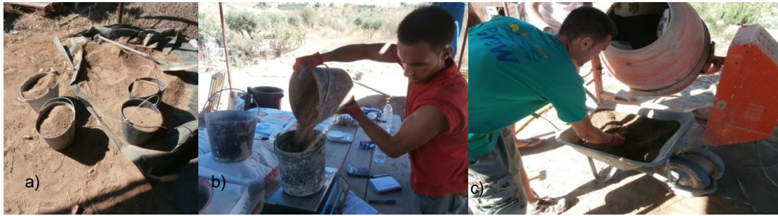
Figura 15 - a) e b) Dosagem dos materiais. c) Mistura dos materiais recorrendo a betoneira elétrica.
