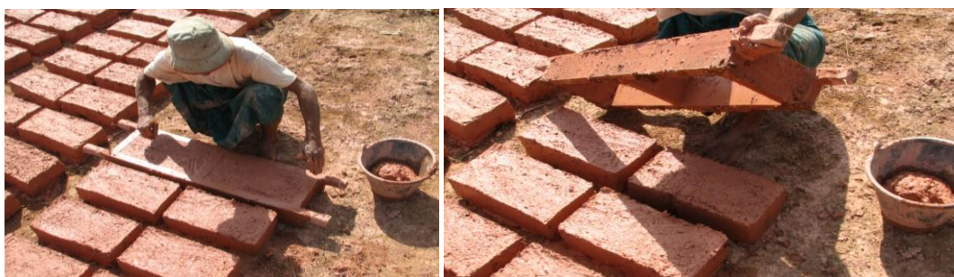
Figura 6 - Desmoldagem de blocos de adobe (Picorelli, 2011).
