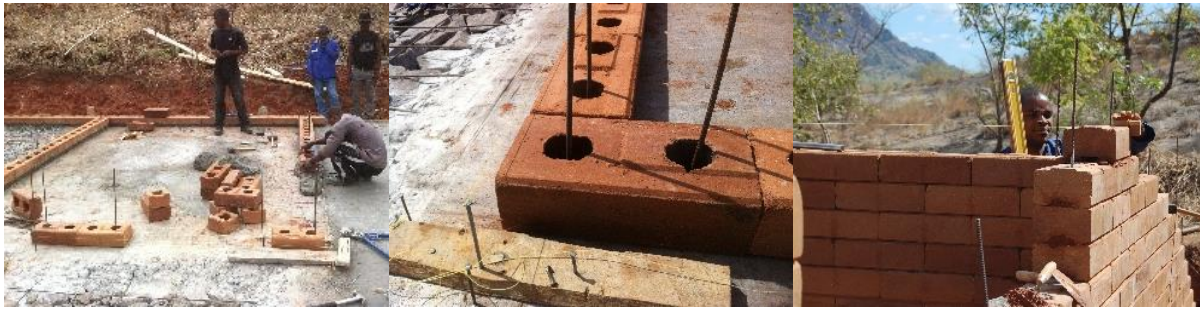
Figura 18 - Processo de construção em BTC, levantamento das paredes. (projeto startup da DwellEarth em Moçambique 2013)
