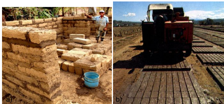
Figura 7 - a) Paredes de adobe em construção. b) Produção mecânica de Adobe (Rael, 2009).
