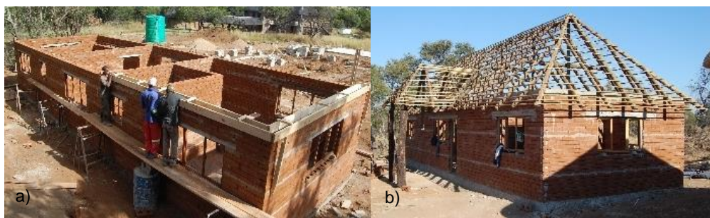
Figura 19 – Processo de construção em BTC: a) Construção da viga de coroamento. b) Construção do telhado. (imagens retiradas do projeto startup da DwellEarth em Moçambique 2013)
