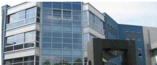
Figura 2.7 - Fachada Envidraçada do Edifício Thomas Cook em Zwijnaerde, Bélgica (Solar Gard, 2015)
