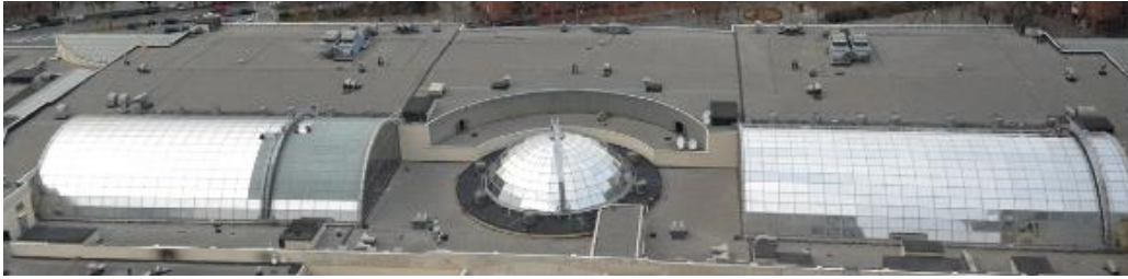
Figura 2.4 - Vista aérea da clarabóia do centro comercial Diagonal Mar em Barcelona (Hanita Coatings, 2015)
