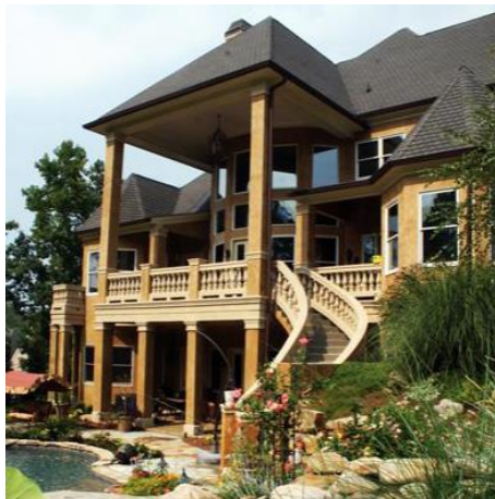
Figura 2.10 - Vista exterior da Habitação em Atlanta Geórgia, EUA (Llumar, 2015)
