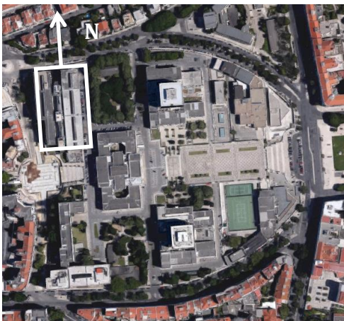
Figura 4.1 - Localização do Pavilhão de Engenharia Civil e Arquitectura e a sua orientação
