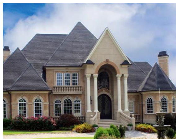
Figura 2.11 - Vista da fachada principal da Habitação em Atlanta Geórgia, EUA (Llumar, 2015)
