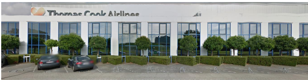
Figura 2.6 - Fachada do Edifício Thomas Cook em Zwijnaerde, Bélgica (Google Street View, 2015)
