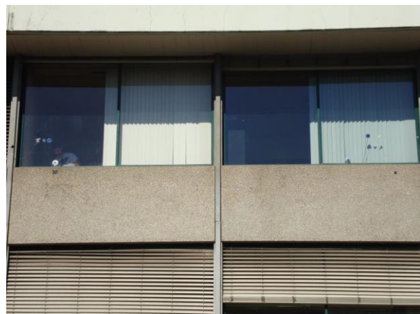
Figura 4.2 - Vista da Fachada Este do Gabinete A (à esquerda) e do Gabinete B (à direita)
