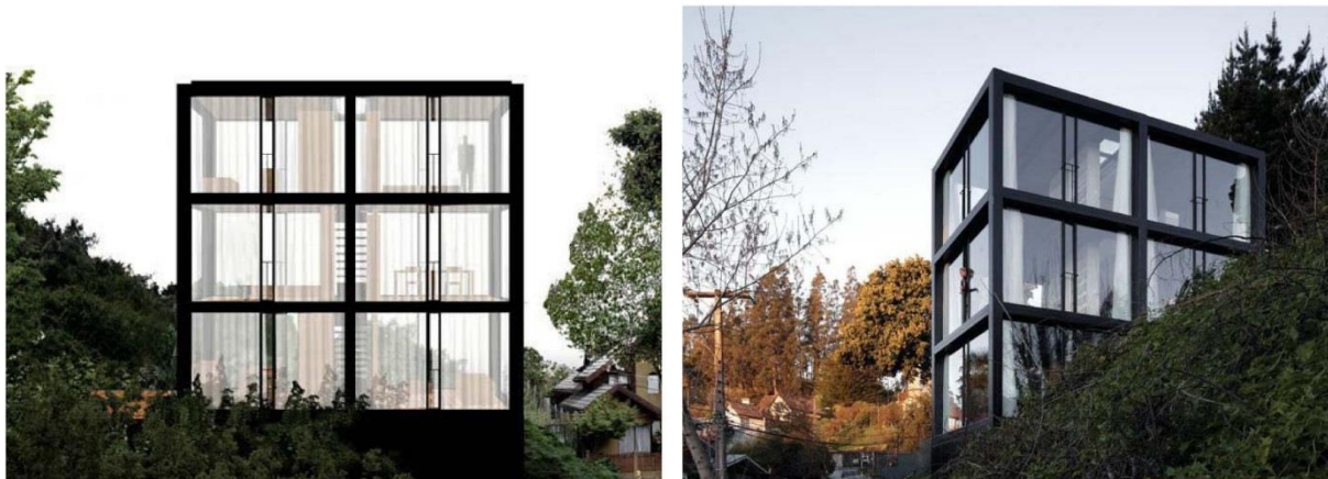
fig. 219-220 - Arco House (Concepción, Chile, 2010-2011), PVE
