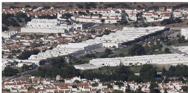
Figura 99: Vista aérea do bairro da Malagueira
