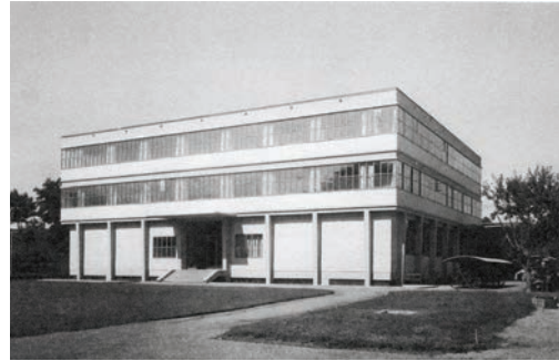
061. Marc J. Saugey, Bâtiment des électrodes, Ateliers de Sécheron (1946-1947).
