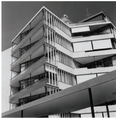
12. South façade. Photo M.-J. Saugey. (Archives IAUG, Fonds Saugey)
