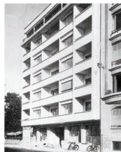
057. Atelier d'architectes, 60 quai Gustave-Addor (1937-1938).
