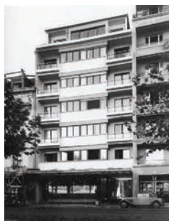
056. Atelier d'architectes, 28 quai Gustave-Addor (1935).
