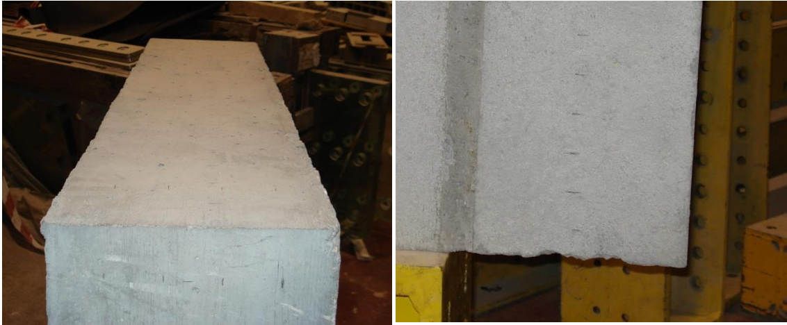
Figura 4.17– Destacamentos e delaminações no protótipo B
