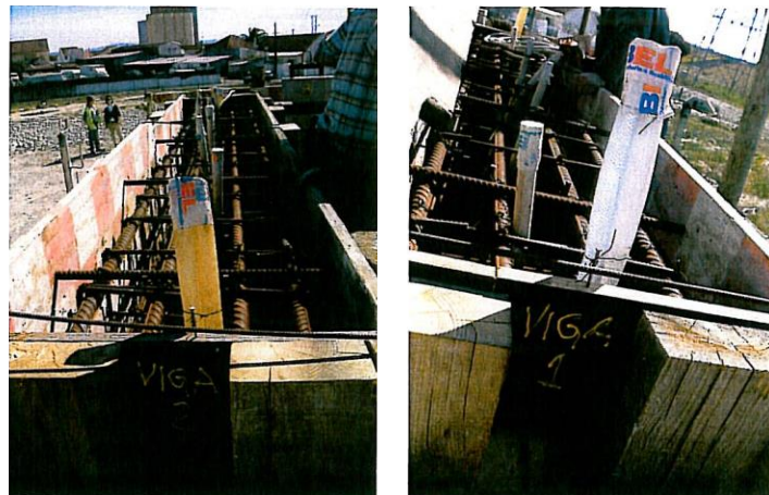
Figura 3.14 – Cofragem dos protótipos. [Almeida et al., 2013]
