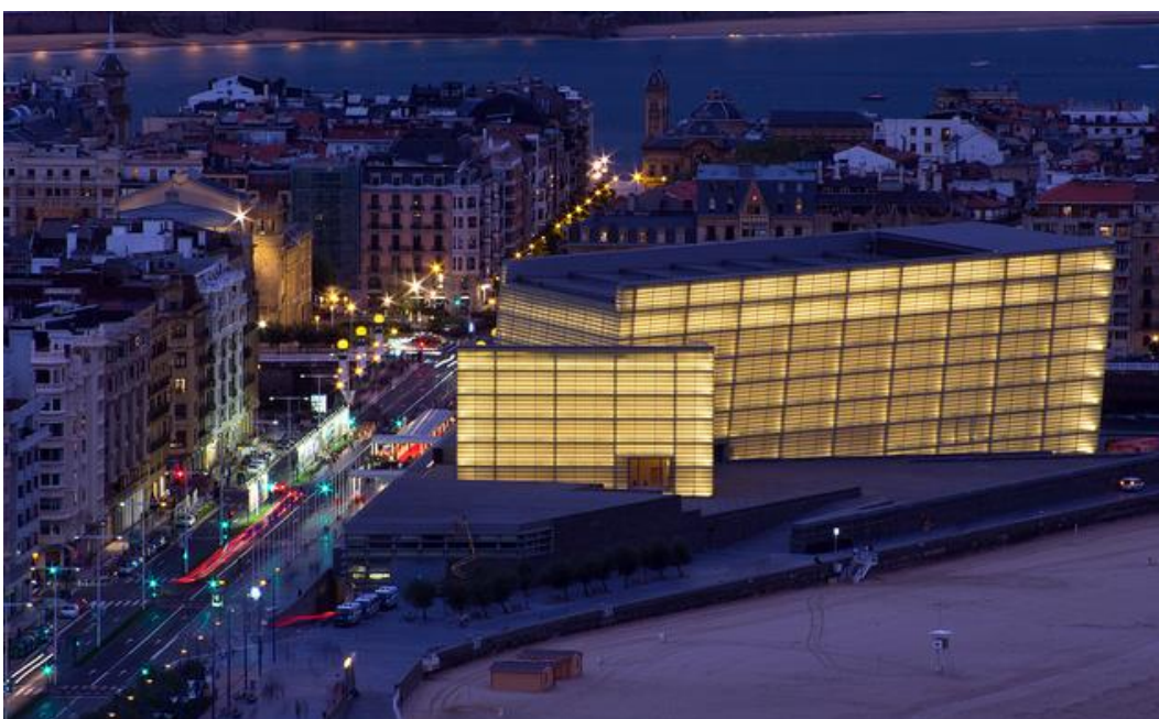
FIG 37 Fotografia noturna. Fonte: arq./a Julho/Agosto 2009
