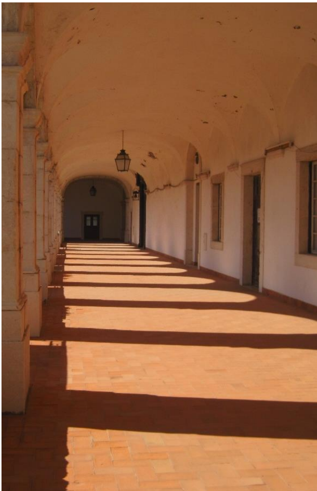
FIG 90 Fotografia do Convento de Santos-o-Novo. Fonte: Autora
