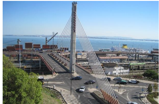
FIG 09 Viaduto Av. Mouzinho de Albuquerque
