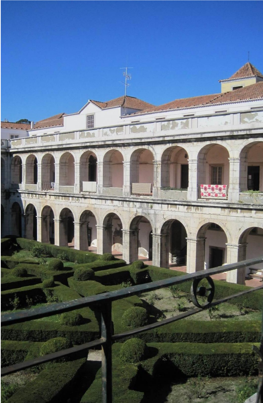
FIG 88 Fotografia do Convento de Santos-o-Novo. Fonte: Autora
